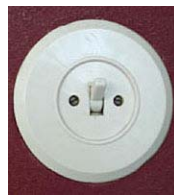
Abb. 8: Lichtschalter: automatisierte Prozesse.
