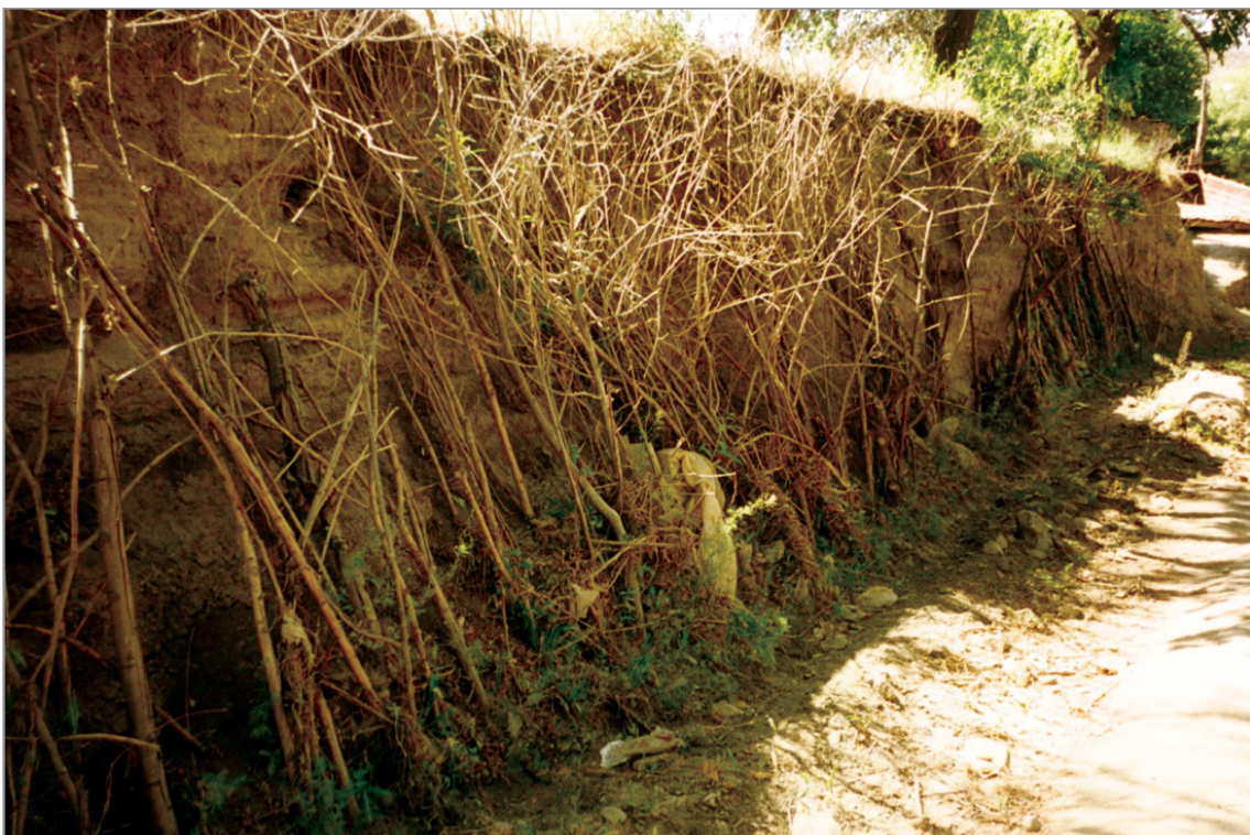
Foto 8: Baumpflanzungen (Weidenstecklinge) als Erosionsschutz entlang der Uferböschung.
