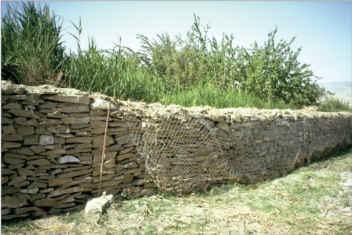
Foto 7: Steinmauern als Erosionsschutz entlang der Uferböschung. Im Hintergrund Melekland.
