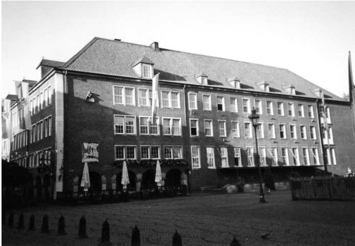
Abb. 81: Düsseldorf. Marktplatz. Verwaltungsgebäude.
