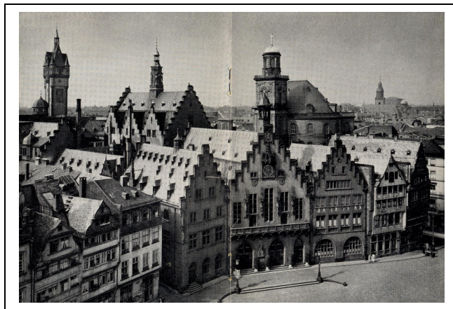
Abb. 96: Frankfurt. Römerberg. Westliche Platzwand vor der Zerstörung
