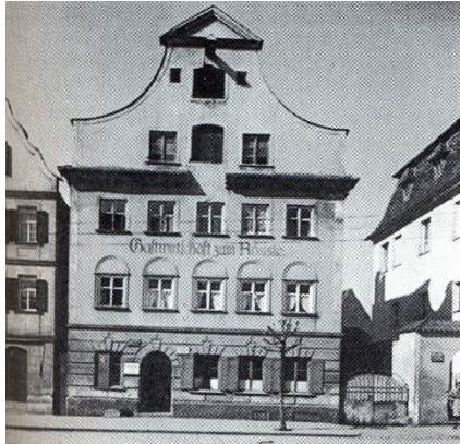
Abb. 163: Günzburg. Marktplatz. Haus Nr.10 vor der Zerstörung.
