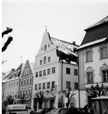
Abb. 164: Günzburg. Marktplatz. Haus Nr.10 nach dem Wiederaufbau.
