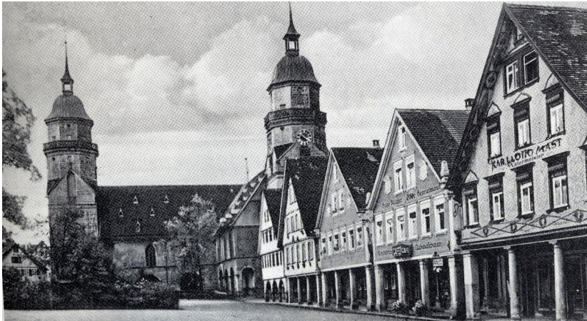
Abb. 140: Freudenstadt. Marktplatz. Östliche Platzwand vor der Zerstörung.
