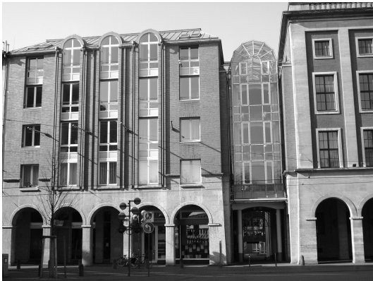
Abb. 395: Neuss. Markt. Rathäuserweiterung.
