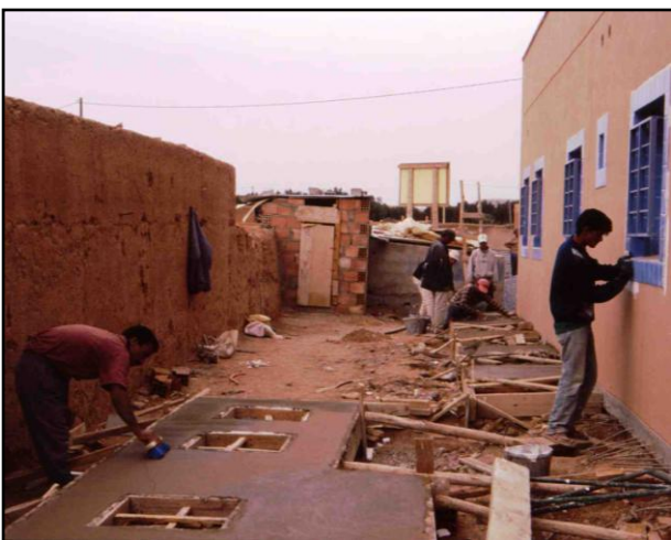
Foto 35: Arbeitsmigranten auf einer Baustelle nahe Goulmim beim Bau einer Krankenstation
