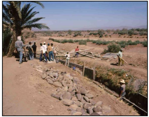
Foto 32: Betonierung der Seguia
