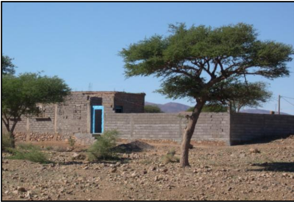
Foto 27: Betonhaus im Bau
