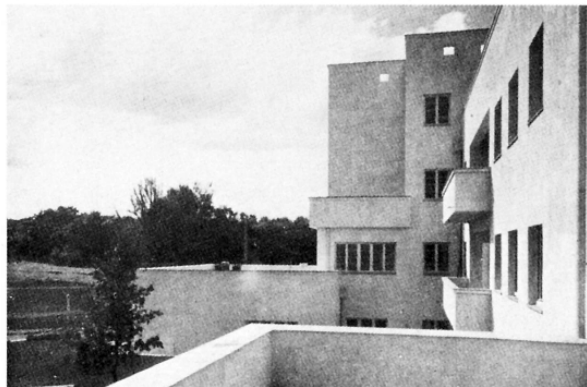
Abb. B.36.: P. Behrens, Terrassenhaus , Stuttgart 1927
