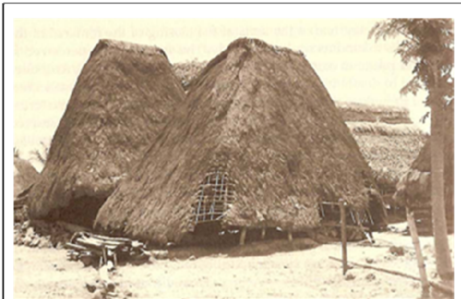
Abb. 47: Palu'é-Haus, 1979 (Vischer 2003, 348, Bild 5, verändert). Die Holzgitterstruktur des Daches ist durch die beschädigte Stelle gut sichtbar.
