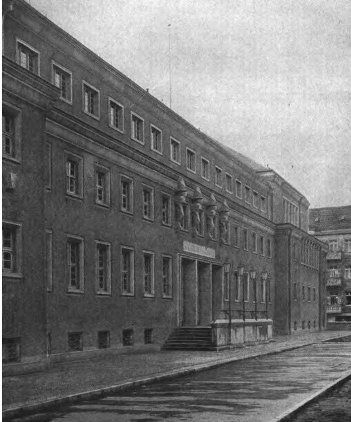
Abb. 2. 8 Hauptfassade Stadtbad Lichtenberg, 1929 (aus: Preindl, Das Städtische Volksbad in Berlin-Lichtenberg, in: Deutsche Bauzeitung, 1929, S. 19, Abb. 1)
