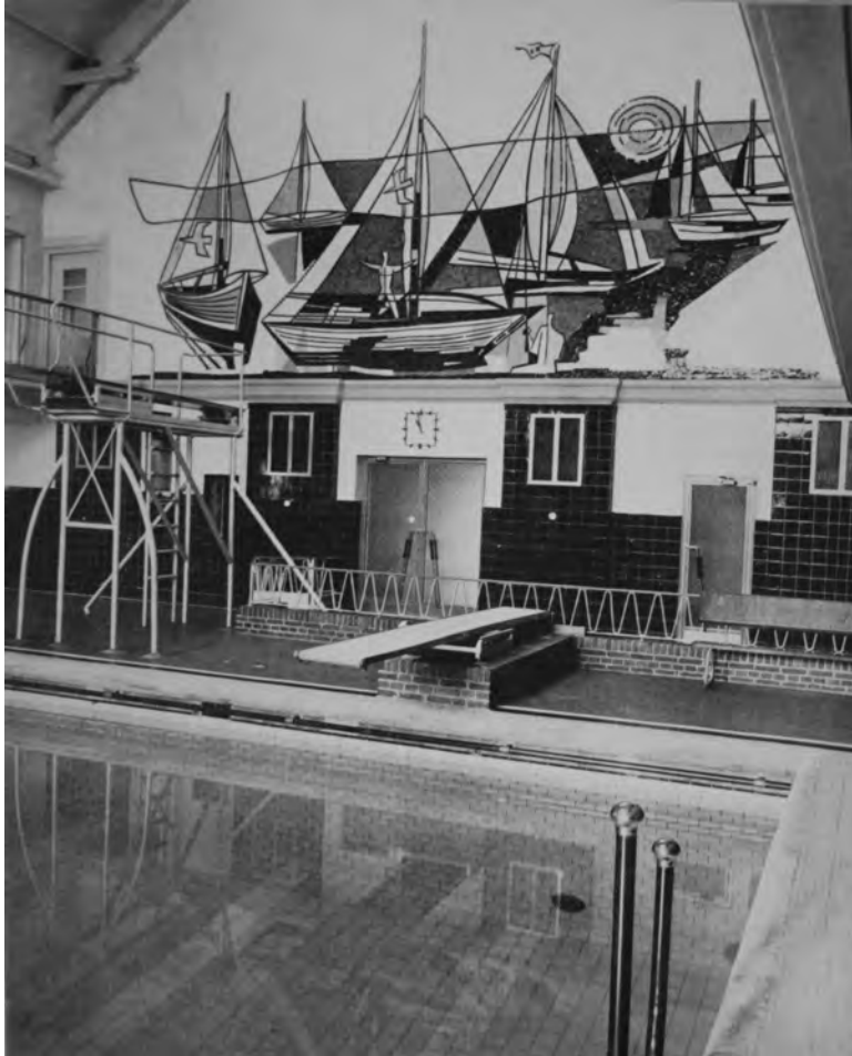
Abb. 17. 5 Schwimmhalle Badeanstalt in Hagen-Boele nach dem Umbau mit Wandmosaik von Carl Baumann, 1957 (aus: Stadt Hagen (Hrsg.), Hagen baut auf: 20 Jahre Entwicklung und Aufbau der Stadt 1945 bis 1964, Hagen 1964, S. 127)
