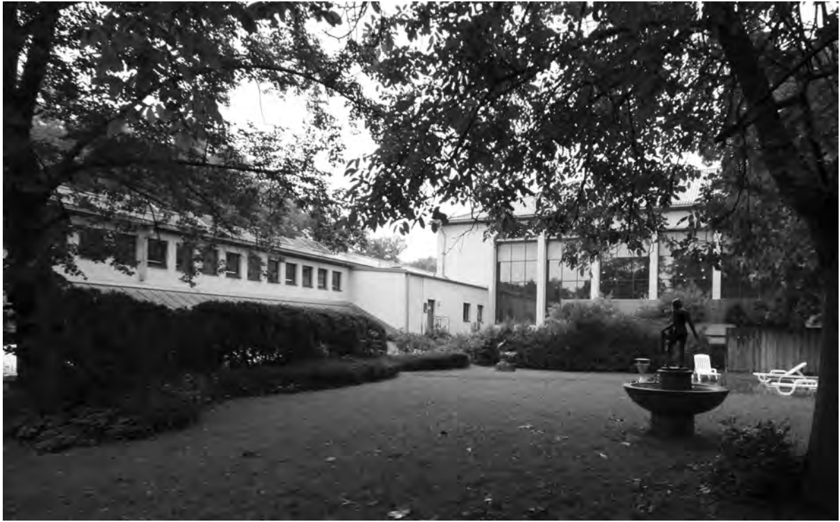
Abb. IX. 21 Rückfassade Sandermare (chem. Hallenschwimmbad) Würzburg, 2014 (Foto: Yasmin Renges)
