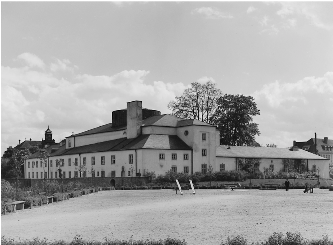
Abb. 33. 10 Rückfassade Ernst-Sachs-Bad in Schweinfurt, 1933 (Bildarchiv ZF Friedrichshafen AG Schweinfurt)
