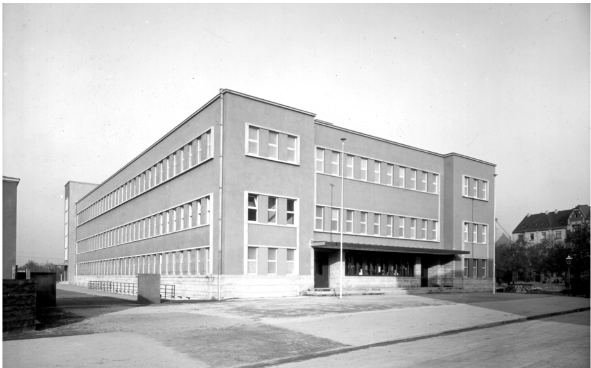
Abb. 10. 6 Volksbad in Dresden-Neustadt-Nordwest, 1929 (Bildstelle Landeshauptstadt Dresden, Nr. II7231)
