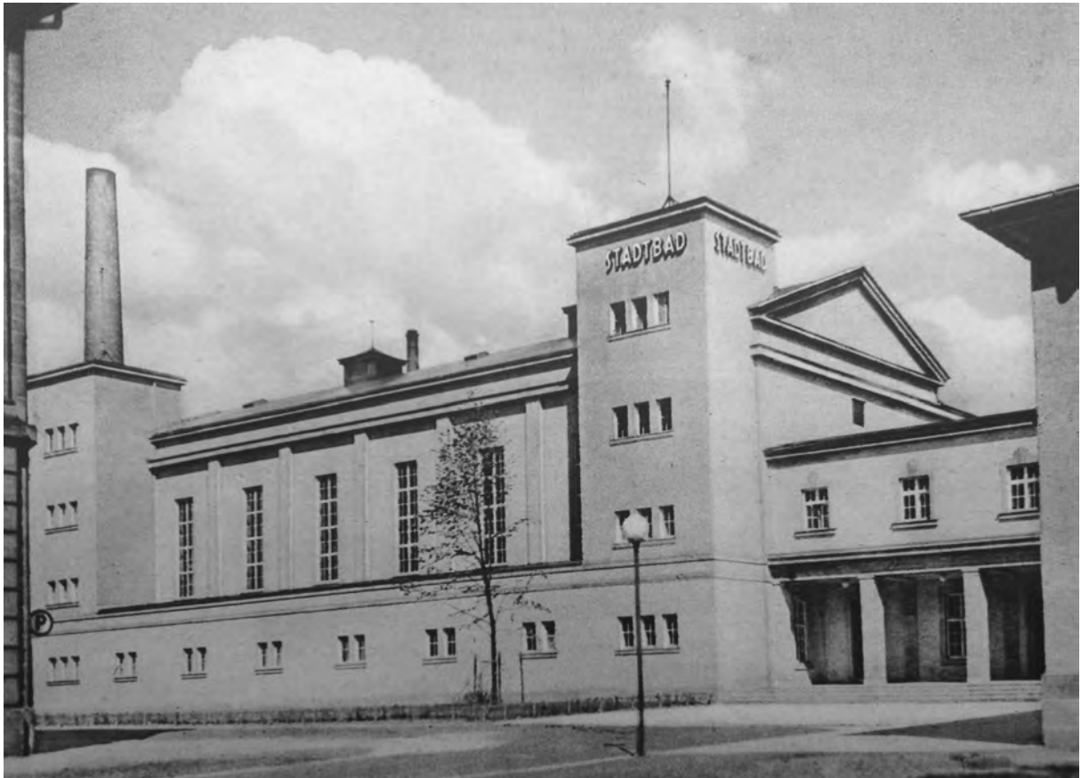
Abb. 1. 7 Hauptfassade Stadtbad Bayreuth, 1931 (aus: Dipl.-Ing. Clas, Stadtbad Bayreuth, in: Bauwelt, 41, 1931, S. 21)
