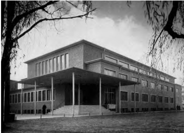
Abb. IX. 26 Stadtbad Harburg, um 1953 (aus: H. Beling, Das Hallenbad in Hamburg-Harburg und die in zwei Jahren gesammelten Betriebserfahrungen, in: AB – Archiv des Badewesens, 6, 1955, S. 149)
