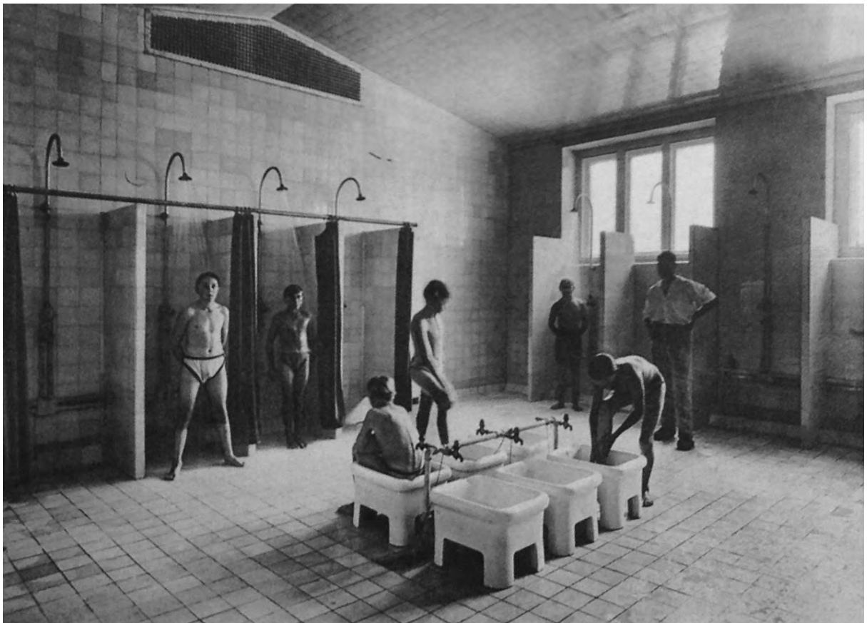
Abb. 4. 11 Reinigungsraum Stadtbad in Berlin-Schöneberg, 1930 (aus: A. L., Stadtbad Berlin-Schöneberg, in: Bauwelt 47, 1930, S. 4)
