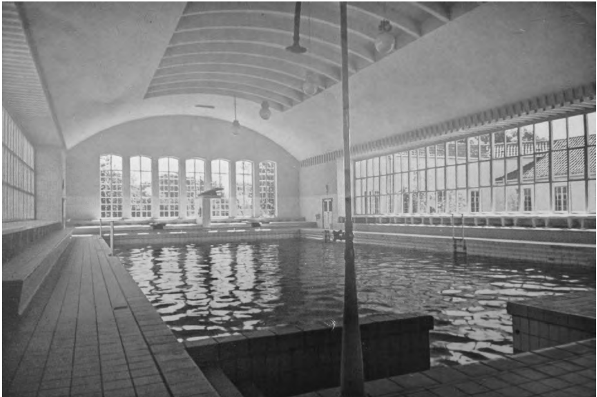
Abb. 22. 19 Schwimmhalle Hallenschwimmbad in Kiel, 1934 (aus: Rudolf Schroeder, Das Hallenschwimmbad in Kiel, in: Der Baumeister, 10, 1936, S. 329)
