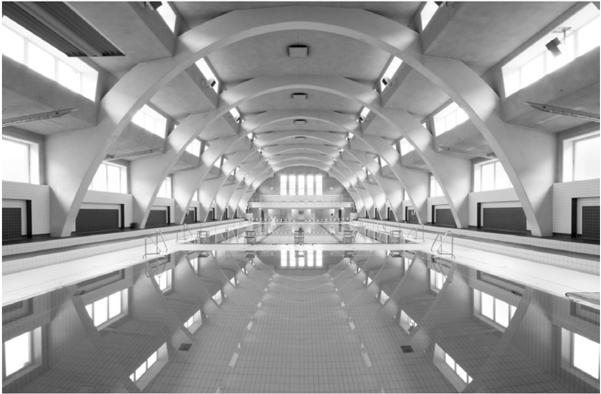
Abb. 36. 14 Schwimmhalle Stadtbad in Stuttgart-Heslach, 2014 (Foto: Yasmin Renges)
