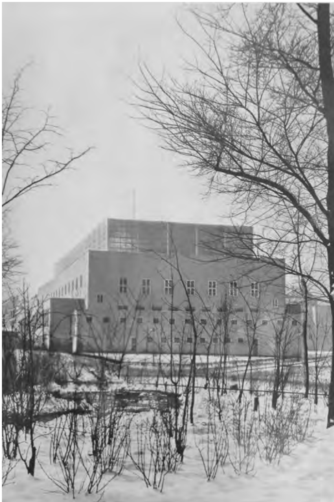
Abb. 9. 5 Rückfassade der großen Schwimmhalle Stadtbad in Chemnitz, 1935 (aus: Otto Härtwig, Walter Schmidt und Fred Otto, Stadtbad Chemnitz, Chemnitz 1935, o. S.)
