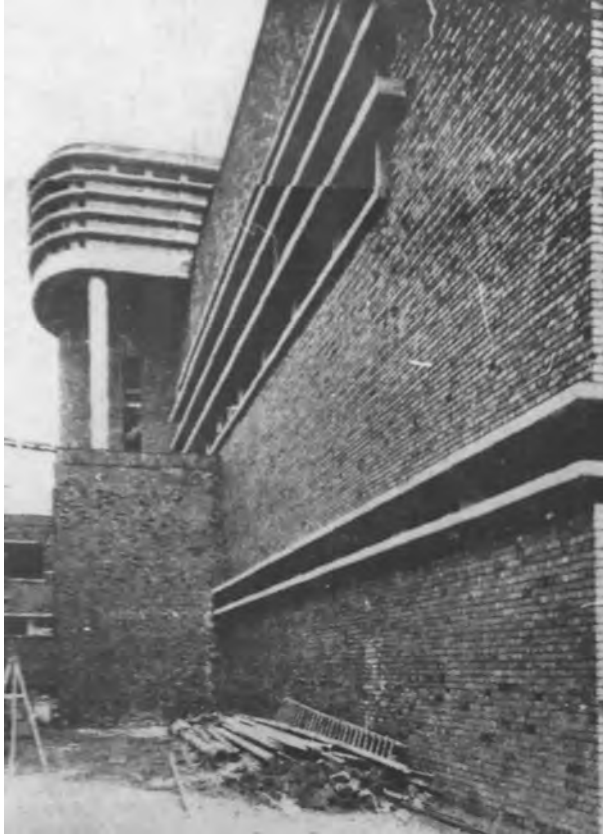
Abb. 13. 10 Hoffassade mit Wasserturm der Badeanstalt in Essen-Altenessen, 1929 (Stadtarchiv Essen, Bestand DZA 915,7 Zeitungsausschnitt aus der Essener Volkszeitung, Die Altessener Badeanstalt im Rohbau fertiggestellt, 9. Dez. 1929)
