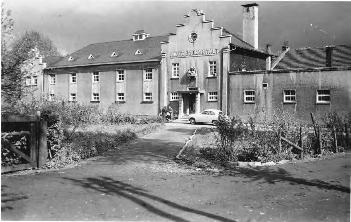
Abb. 31. 7 Hauptfassade Badeanstalt in Lüttringhausen, um 1957 (Historisches Zentrum Stadt Remscheid, Bildarchiv)
