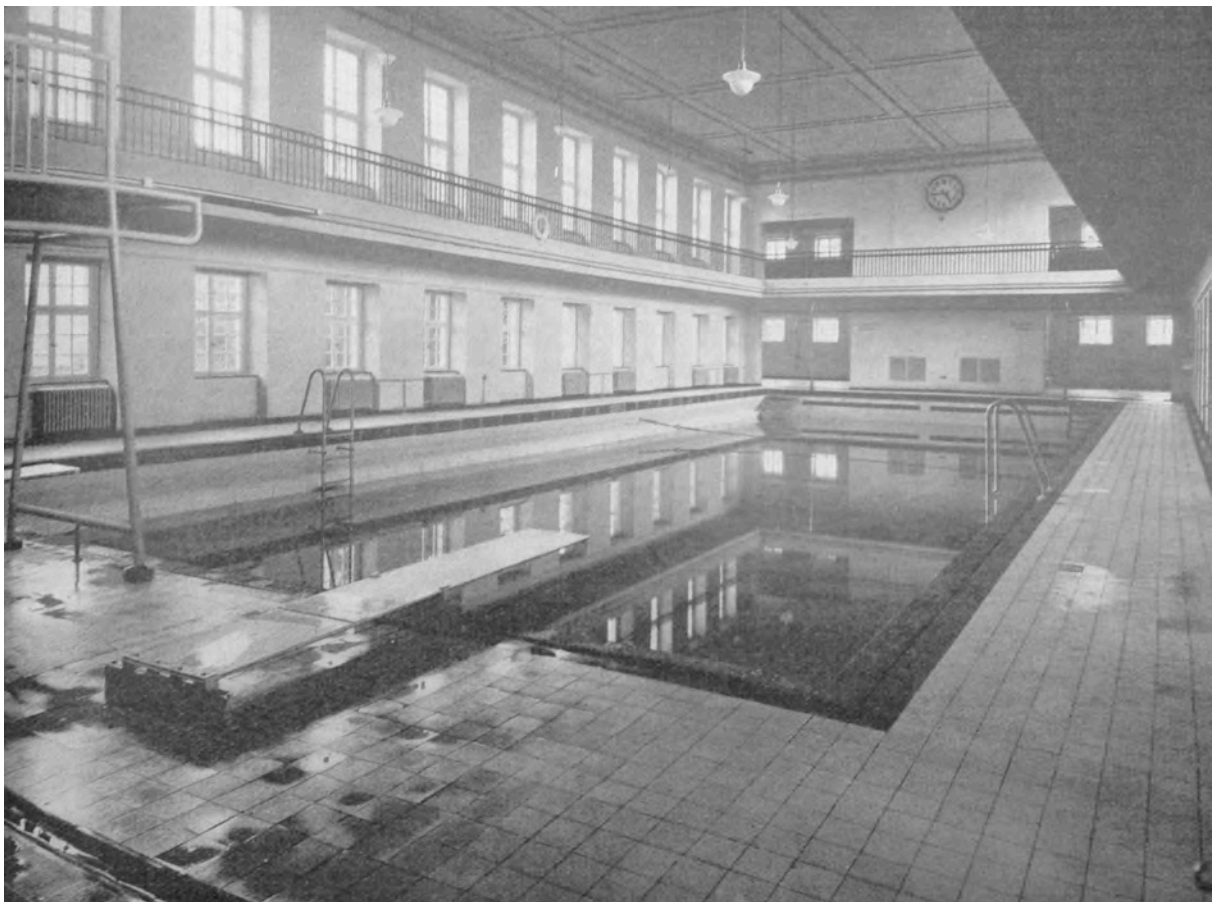
Abb. 26. 8 Schwimmhalle Luisabad in Marburg a. d. Lahn, 1930 (aus: O. A., Das neue Hallenschwimmbad in Marburg a. d. Lahn, in: Deutsches Schwimmerblatt, 12, 1930, S. 45)
