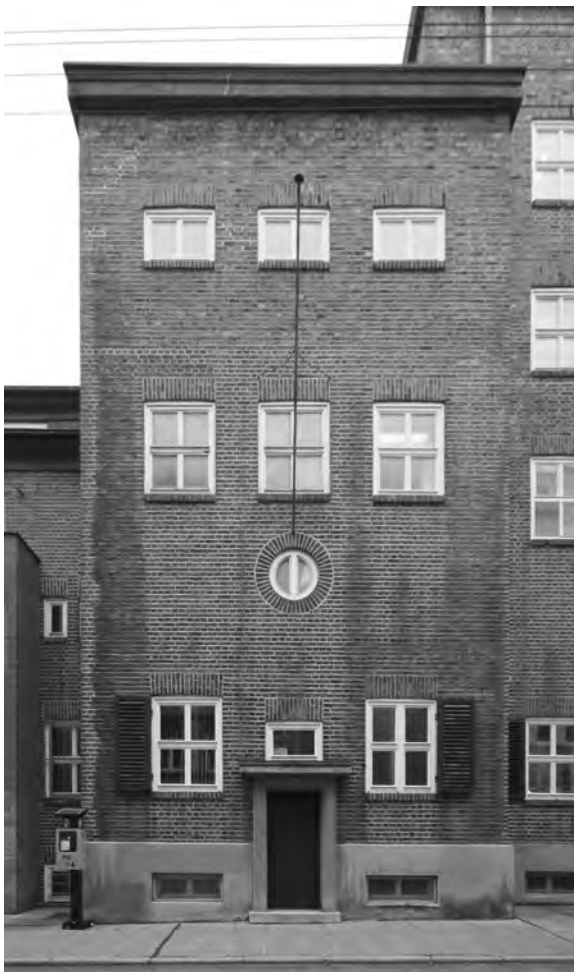
Abb. 36. 13 Eingang zur Personalwohnung Stadtbad in Stuttgart-Heslach, 2014 (Foto: Yasmin Renges)
