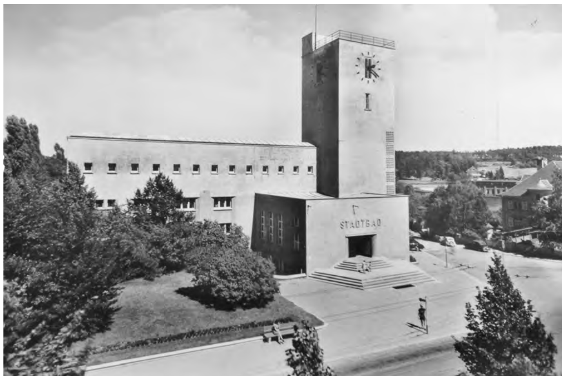
Abb. 29. 8 Hauptfassade Stadtbad in Pirmasens, o. J. (Stadtarchiv Pirmasens, Bildarchiv Sammlung Stadtbad)
