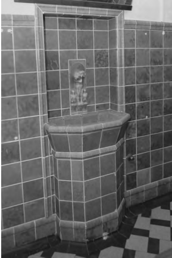
Abb. 31. 9 Wandbrunnen der Badeanstalt in Lüttringhausen, 2003 (Bauaktenarchiv Stadt Remscheid, Fotodokumentation der Städt. Badeanstalt Lüttringhausen, Sept. 2003)
