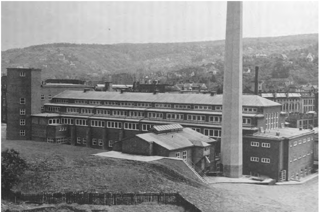
Abb. 36. 7 Rückfassaden Stadtbad in Stuttgart-Heslach, 1929 (aus: Stadtbad Stuttgart-Heslach: Zur Eröffnung am 15. Juni 1929, Stuttgart 1929, S. 7)
