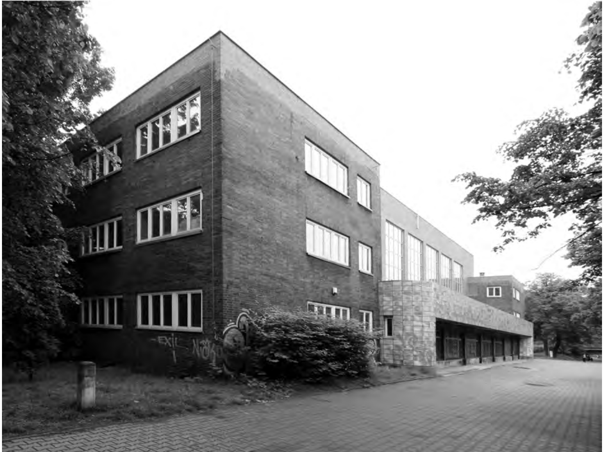
Abb. 5. 7 Südfassade mit ehem. Geschäftsläden Pływalnia Kryta in Bytom, 2015 (Foto: Yasmin Renges)
