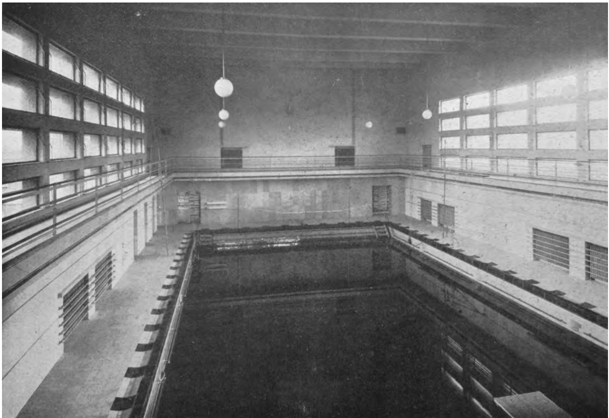
Abb. 13. 11 Schwimmhalle Badeanstalt in Essen-Altenessen, 1930 (aus: Ernst Bode, Städtische Badeanstalt Essen-Altenessen, in: Bauwarte, 51, 1930, S. 555, Abb. 12)
