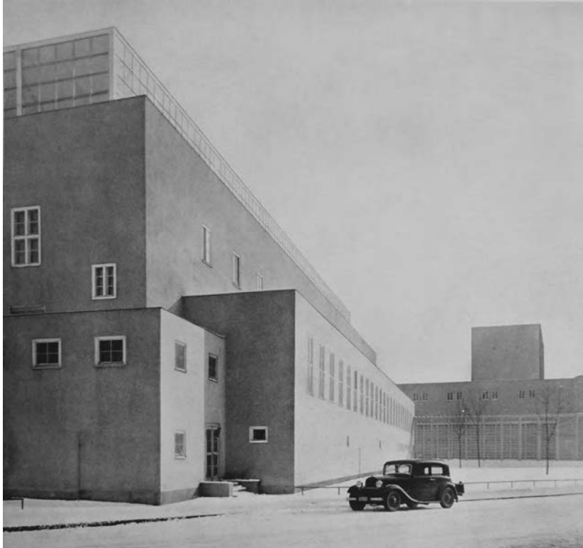
Abb. 9. 6 Ansicht von der Rochlitzerstr. in Stadtbad Chemnitz, 1935 (aus: Otto Härtwig, Walter Schmidt und Fred Otto, Stadtbad Chemnitz, Chemnitz 1935, o. S.)
