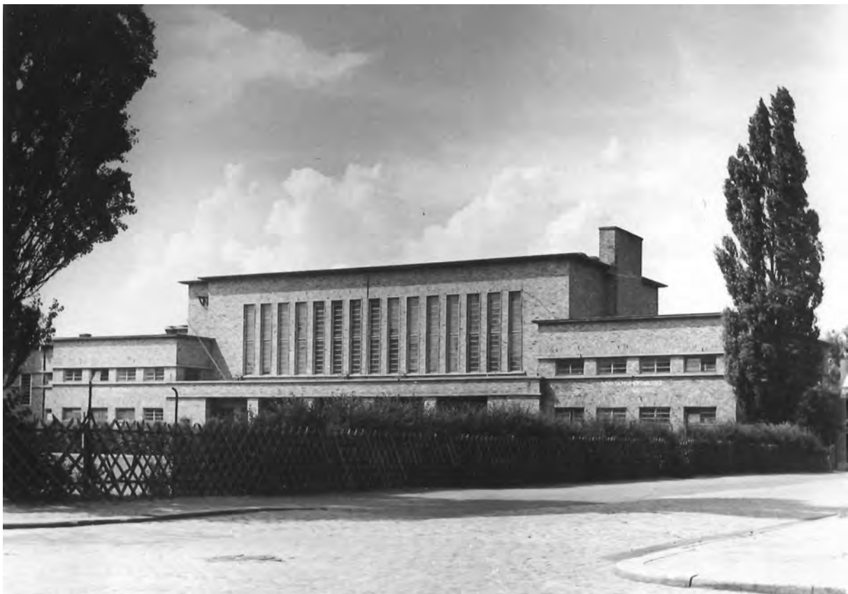
Abb. 6. 7 Rückfassade Friedrich-Ebert-Bad in Brandenburg an der Havel, o. J. (Stadtarchiv Brandenburg, L1.-21B, Nr. 27)
