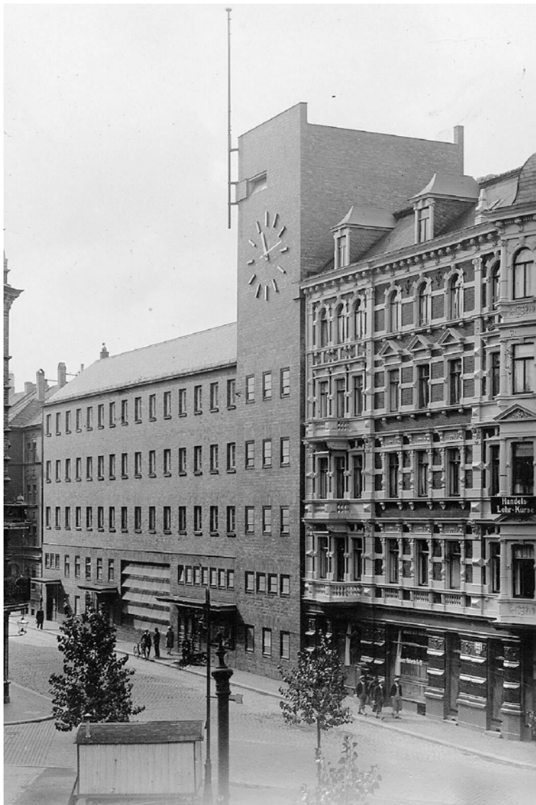
Abb. 24. 9 Hauptfassade Hallenbad West in Leipzig-Lindenau, 1930 (Stadtarchiv Leipzig, BA 1977_2927; Foto: Alfons Trapp)
