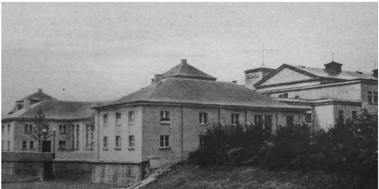
Abb. 1. 8 Ansicht von Südosten mit Turnhalle des Stadtbaus Bayreuth, 1931 (aus: Dipl.-Ing. Clas, Stadtbad Bayreuth, in: Bauwelt, 41, 1931, S. 21)
