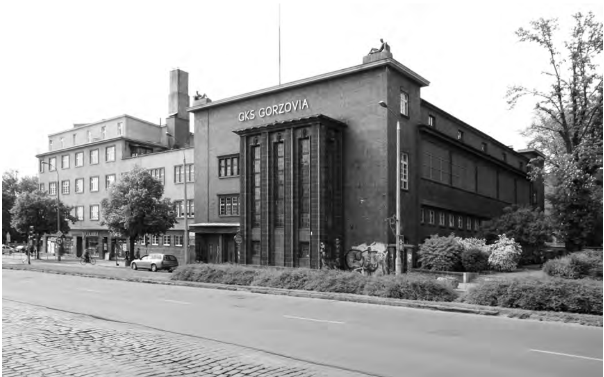
Abb. 23. 10 Ehemaliges Volksbad und Wohnhaus mit Läden in Gorzów Wielkopolski, 2015 (Foto: Yasmin Renges)
