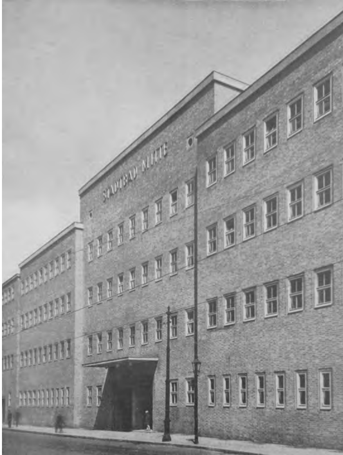
Abb. 3. 8 Hauptfassade Stadtbad Mitte in Berlin, 1930 (aus: O. A., Das Stadtbad Berlin-Mitte, in: Deutsches Bauzeitung, 64, 1930, S. 445)
