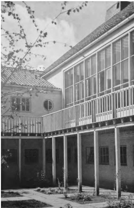
Abb. 22. 20 Innenhof mit Umgang Hallenschwimmbad in Kiel, 1934 (aus: Rudolf Schroeder, Das Hallenschwimmbad in Kiel, in: Der Baumeister, 10, 1936, S. 327)
