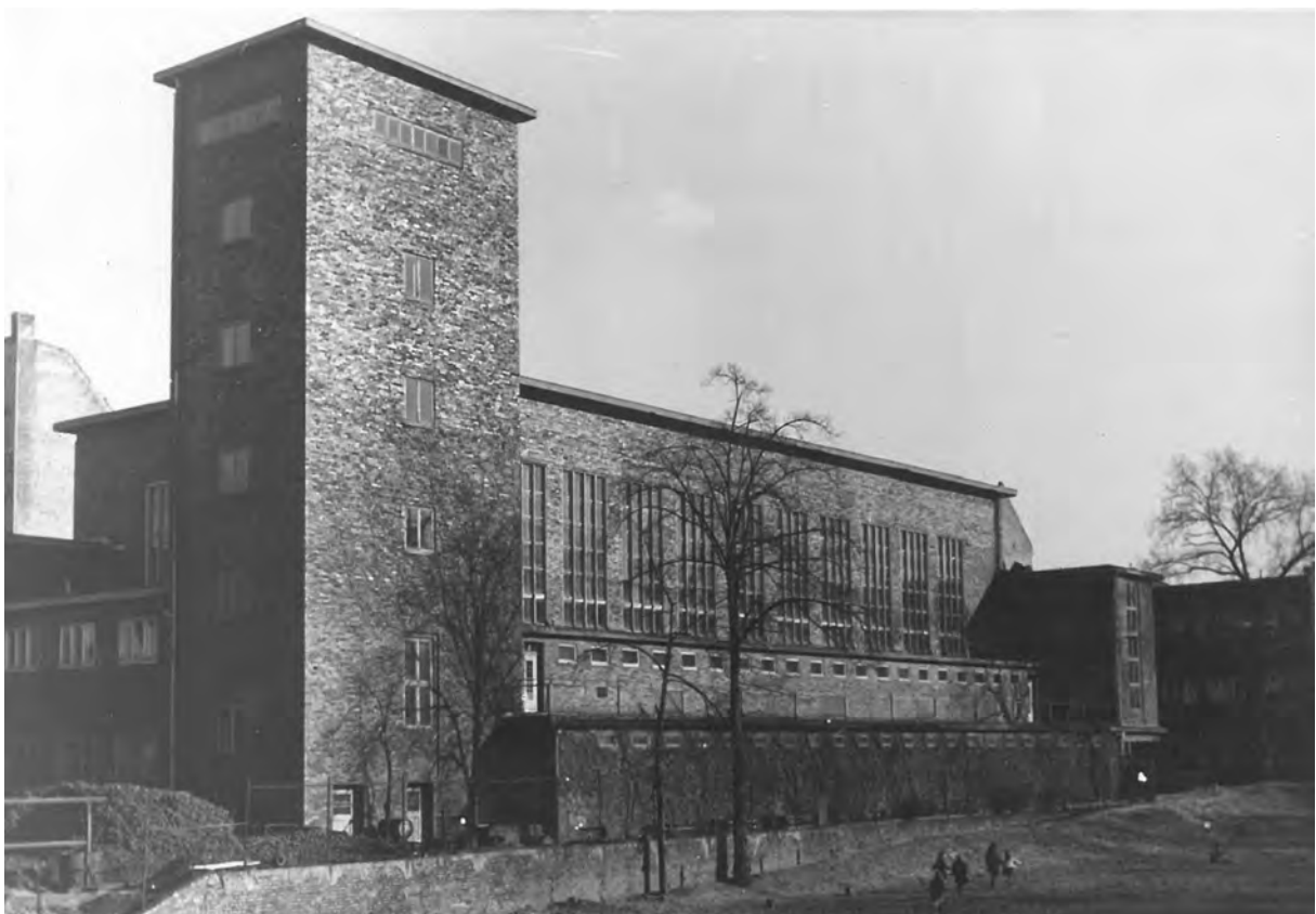
Abb. 4. 8 Westfassade mit Wasserturm Stadtbad in Berlin-Schöneberg, um 1930 (Untere Denkmalschutzbehörde, Bezirksamt Tempelhof-Schöneberg von Berlin, Akte Hauptstraße 38-39)
