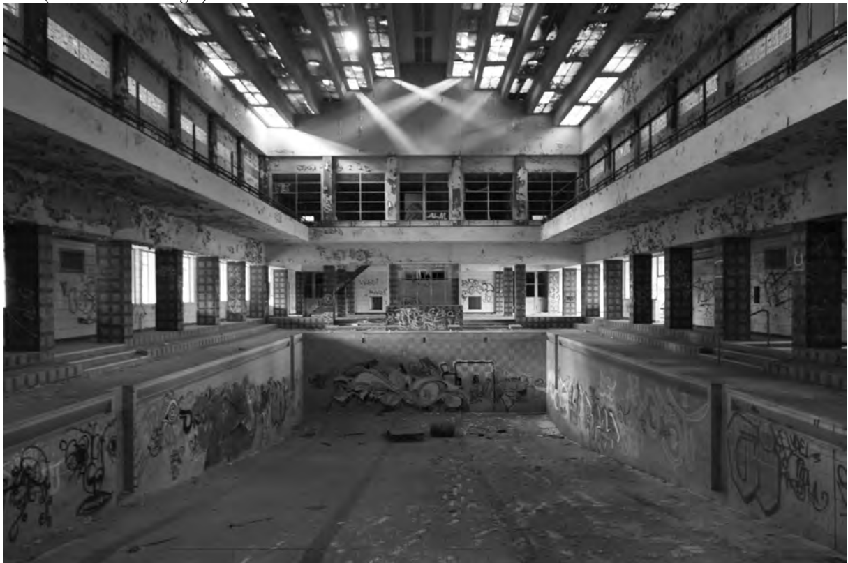
Abb. 10. 16 Schwimmhalle Sachsenbad in Dresden-Neustadt-Nordwest, 2014 (Foto: Yasmin Renges)
