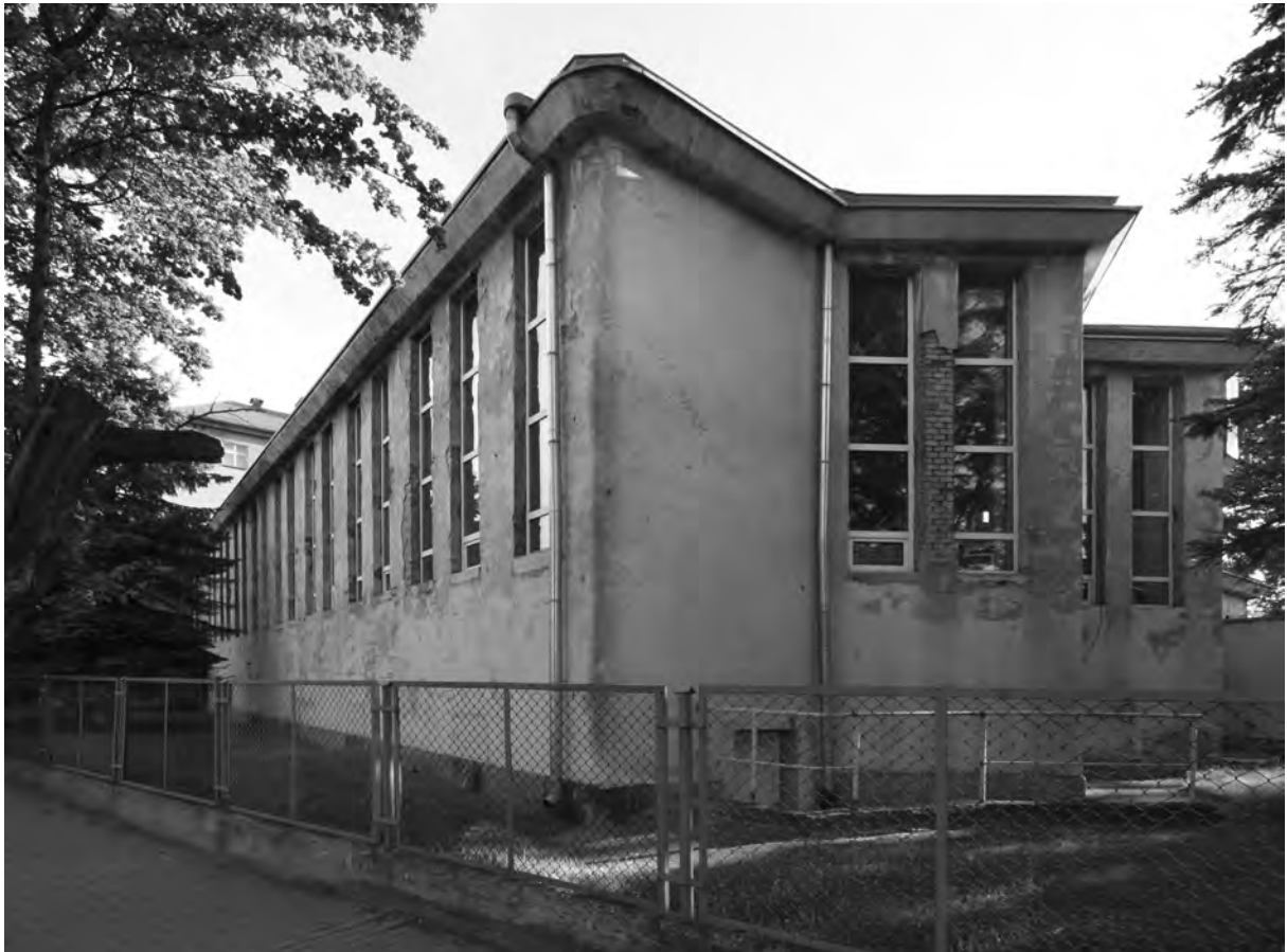
Abb. 30. 6 Rückfassade der Schwimmhalle Basen Kryty in Dzierżoniów, 2015 (Foto: Yasmin Renges)
