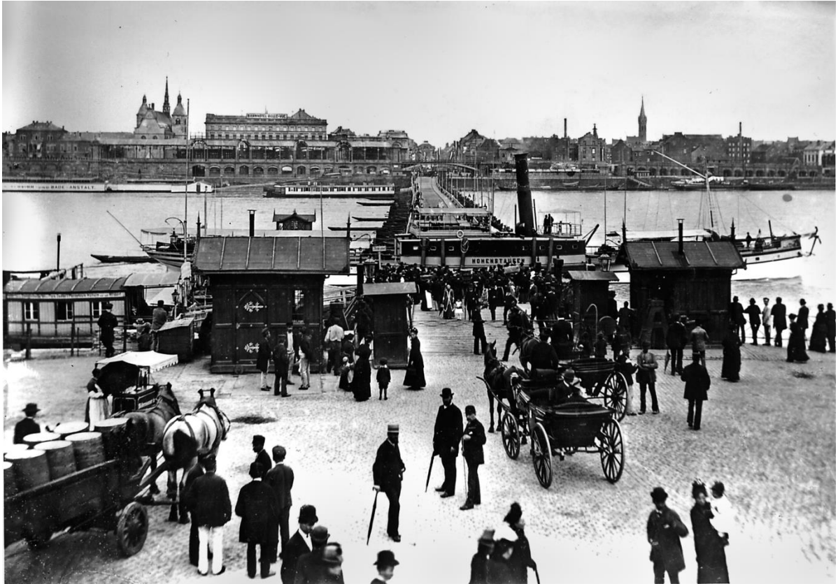
Abb. 32 Die Schiffbrücke mit Blick nach Osten bei ausgefahrenen Brückenjochen, um 1890. Gerade passiert ein Dampfschiff den Durchlass der Schiffbrücke. Im Vordergrund die auf die Öffnung der Schiffbrücke wartenden Fuhrwerke und Passanten. Im Hintergrund das Deutzer Rheinufer mit dem Bahndamm der Bergisch-Märkischen Eisenbahn. Quelle: RBA
