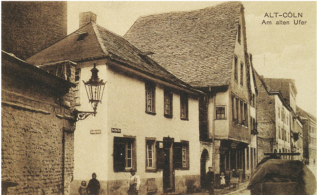
Abb. 26 Postkarte mit Blick in die Straße Am Alten Ufer nach Norden, um 1909. Links die Einmündung der Goldgasse. Der hier gezeigte Straßenabschnitt befand sich auf der Rückseite des alten Eisenbahnverwaltungsgebäudes.
