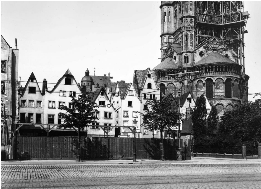
Abb. 119 Blick von Osten auf die freigeräumten Bauplätze für die beiden Neubauten Frankenwerft 27 und 29 im Frühjahr 1910. Im Hintergrund die Altbauten auf der Westseite des Buttermarktes. Rechts die Gartenanlage im Süden des Stapelhauses. Quelle: RBA
