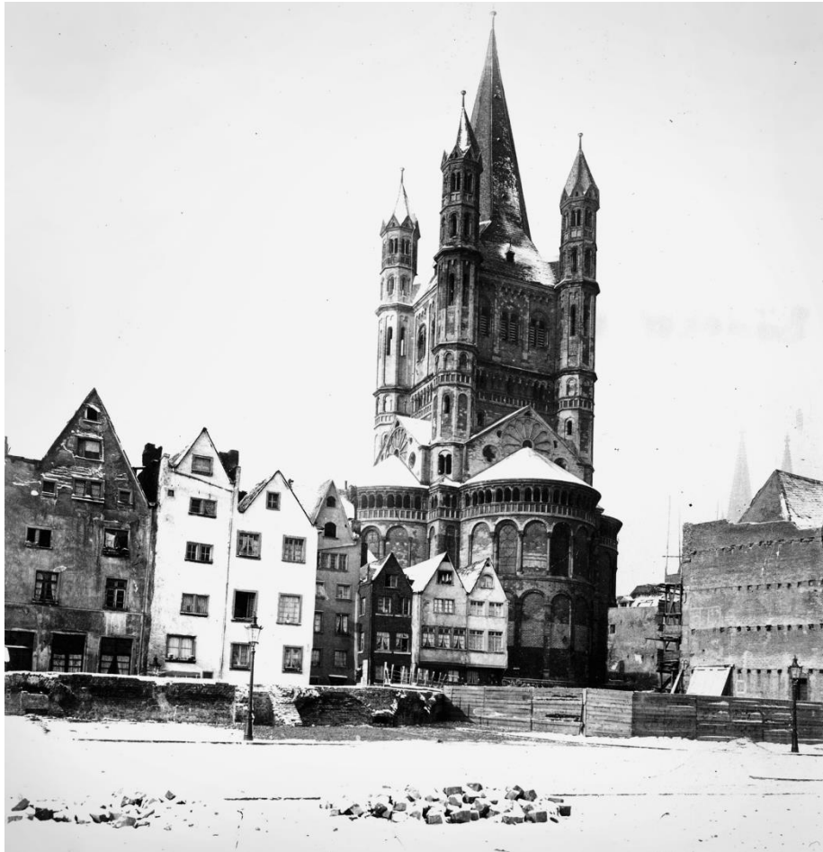
Abb. 99 Die eingezäunte Baustelle des Stapelhauses (rechts) nach der Niederlegung des benachbarten Lagerhauses Ahren im Januar 1900. Quelle: Stadt Köln, Konservator
