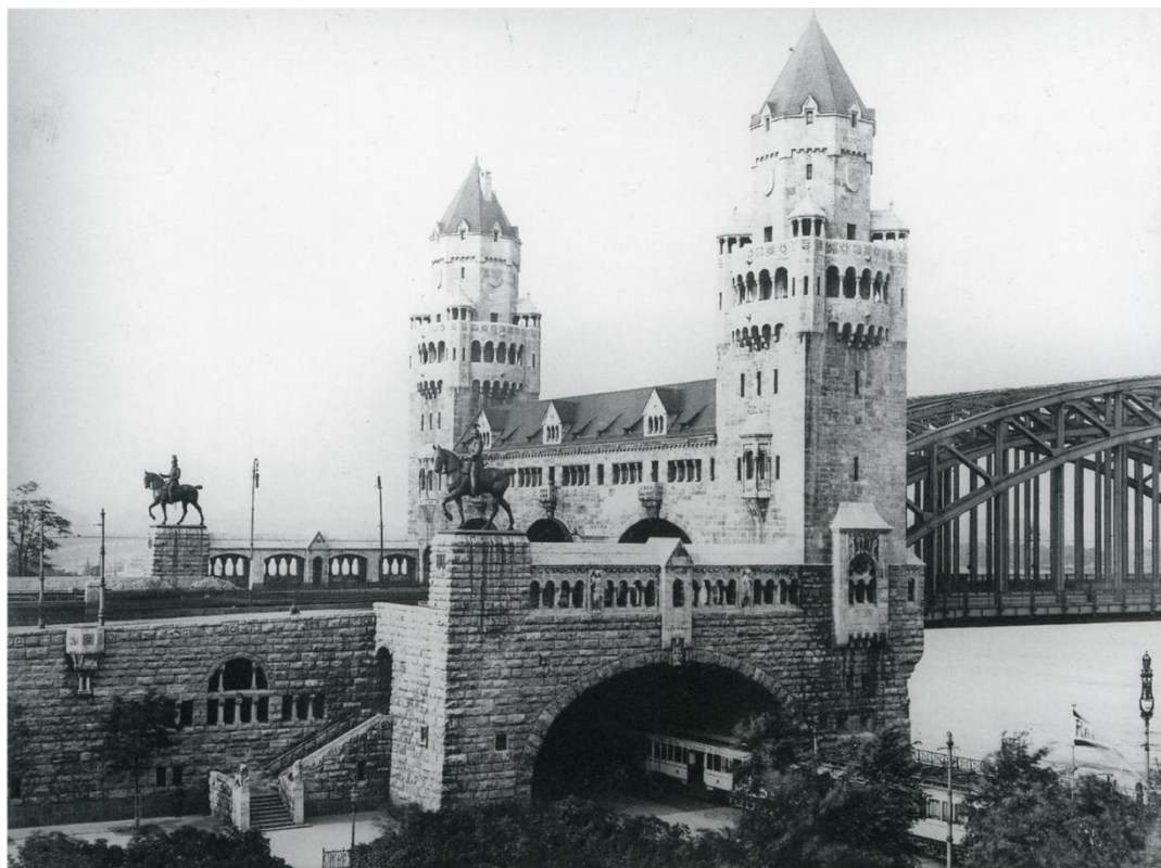
Abb. 126 Blick von Südwesten auf den linksrheinischen Landpfeiler der Hohenzollernbrücke, nach 1911. Im Zentrum der Portalbau und die Aussichtsgalerie oberhalb der Frankfurterunterführung. Quelle: RBA
