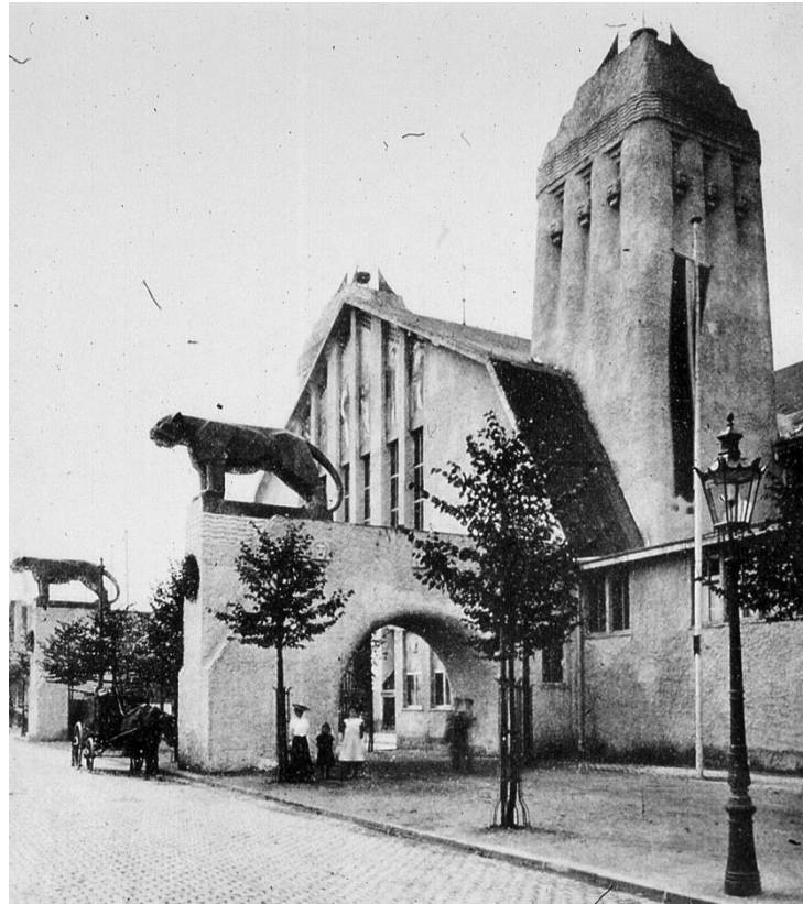
Abb. 146 Der Haupteingang der im Jahre 1905 für die Ausstellung von Handwerks- und Kunsthandwerkserzeugnissen des Regierungsbezirks Köln am Kaiser-Friedrich-Ufer errichteten Halle von Nordosten. Quelle: Renard 1906, S. 10
