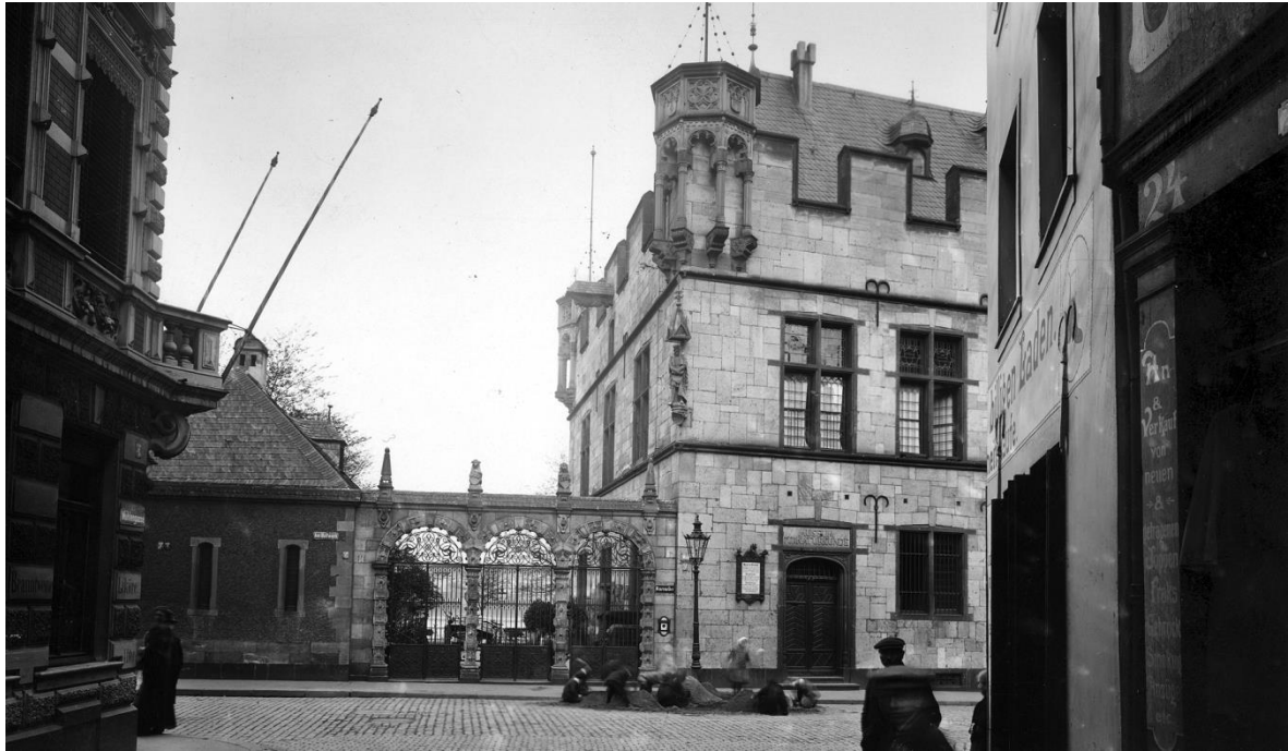
Abb. 110 Blick aus der Mühlengasse nach Osten, um 1905. Rechts das Stapelhaus, links die Rückseite der Halle des im Sommer 1902 eröffneten Konzertgartens. Zwischen diesen Gebäuden die Arkade des im Jahre 1899 niedergelegten Hauses Bingen, Holzmarkt 67. Quelle: RBA
