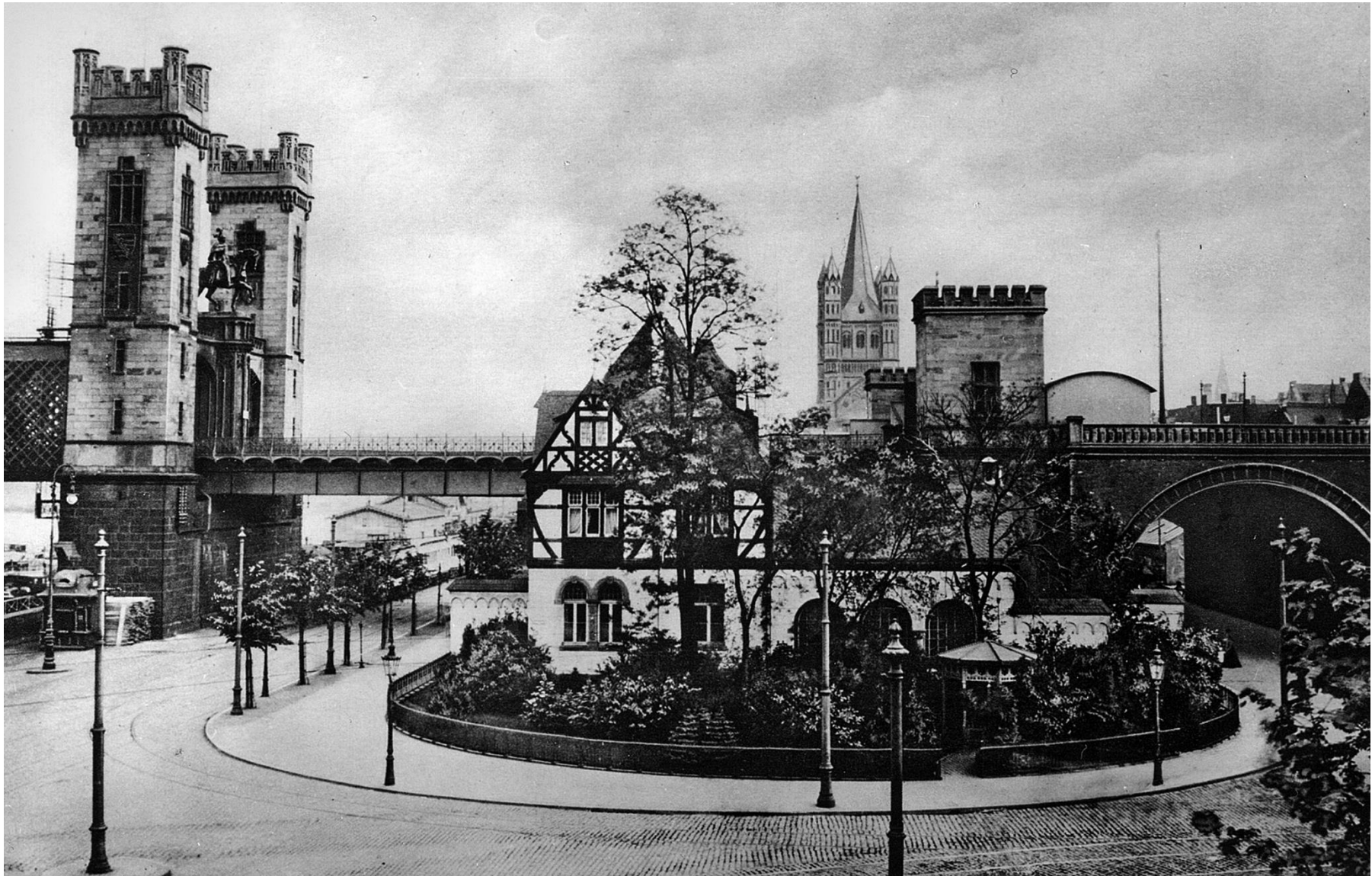
Abb. 74 Der Betriebs- und Verwaltungsbau der Pumpstation für das Tiefland im Norden der Dombrücke mit Blick nach Süden im Jahre 1900. Links die Rheinuferstraße, im Vordergrund die Trankgasse, rechts der in die Trankgasse mündende nördliche Teil der Straße Am Frankenturm. Quelle: RBA
