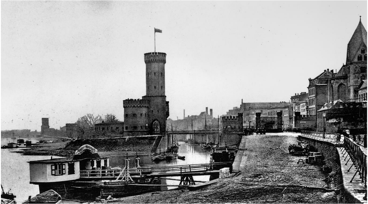
Abb. 18 Blick von Norden auf den Hafeneingang des Sicherheitshafens an der Rheinmündung im Jahre 1884. Rechts die Holzwerft mit der vorgelagerten Rheingassenrampe. Auf der Spitze der Halbinsel der Malakoffturm, gegenüber auf der Landseite ein Blockhaus und das Holztor, das unmittelbar im Süden der Kirche St. Maria Lyskirchen an die stadtheitigen Häuser anschloss. Quelle: Festschrift Hafen 1898, Tafel 8
