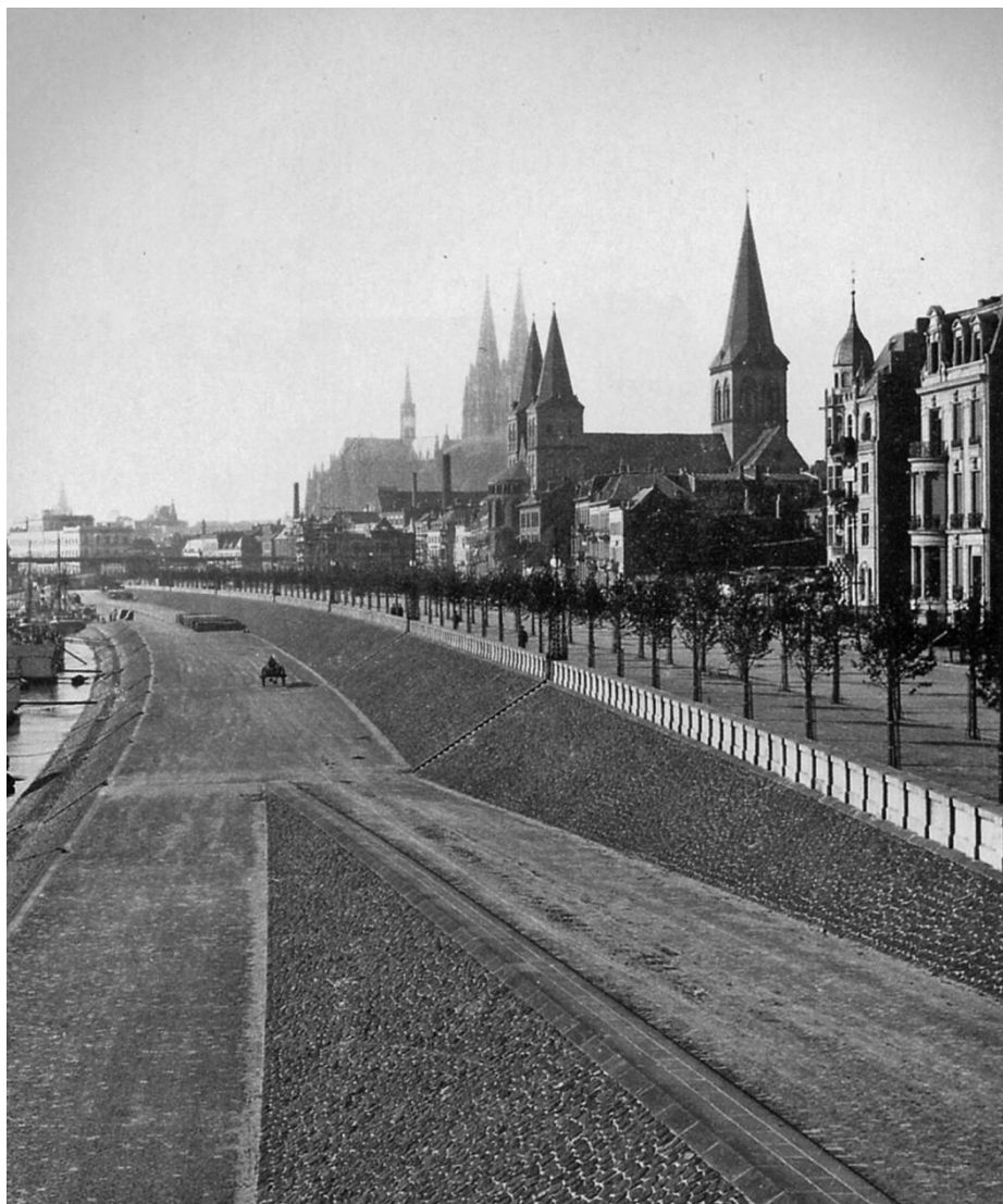
Abb. 77 Blick von der Kaponniere nach Süden, um 1902. Links die tiefer gelegene Kaiser-Friedrich-Werft, rechts das Kaiser-Friedrich-Ufer mit der sich hinter der Brüstungsmauer erstreckenden Alleepromenade. Quelle: Stadt Köln, Konservator
