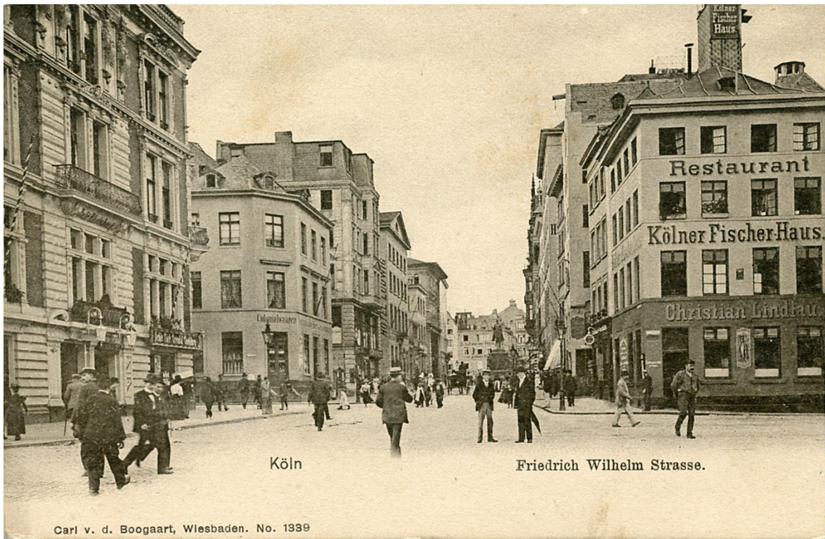
Abb. 42 Postkarte mit Blick in die Friedrich-Wilhelm-Straße nach Westen, vor 1903/04. Links die Nordfront des 1888 fertiggestellten Eckgebäudes Friedrich-Wilhelm-Straße 12, Ecke Leystapel (Café Rheinberg). Rechts der Altbau Friedrich-Wilhelm-Straße 15 an der Ecke zur Hafengasse (Frankenwerft).
