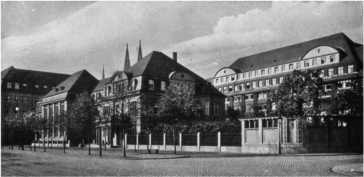
Abb. 154 Blick von Nordosten auf das Nebengebäude der Eisenbahndirektion (links) und den Garten der Villa des Direktionspräsidenten (rechts) am Kaiser-Friedrich-Ufer im Jahre 1914. Rechts im Hintergrund das fertiggestellte Gewerbehaus Am alten Ufer. Quelle: Klapheck 1914, S. 15
