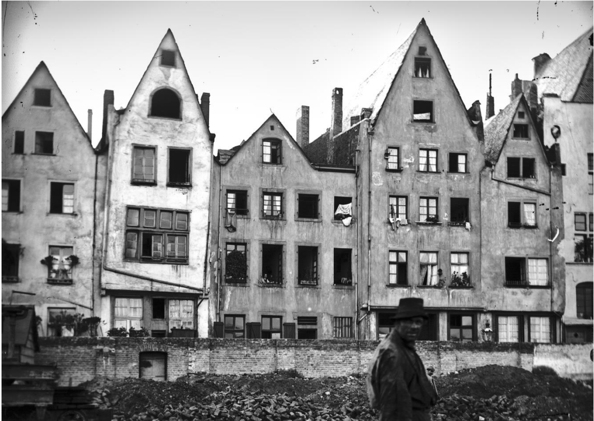
Abb. 59 Blick auf einige der alten Häuser an der Hafengasse im Jahre 1898 während des Abrisses des Zollhafens.
