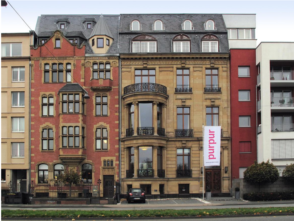
Abb. 131 Die erhaltenen Wohnbauten am Konrad-Adenauer-Ufer 65 (links) und 67 (rechts), ehemals Kaiser-Friedrich-Ufer 65 und 67, im Jahre 2013. Die ursprünglichen Dächer sind heute verändert. Quelle: Fotografie der Verfasserin
