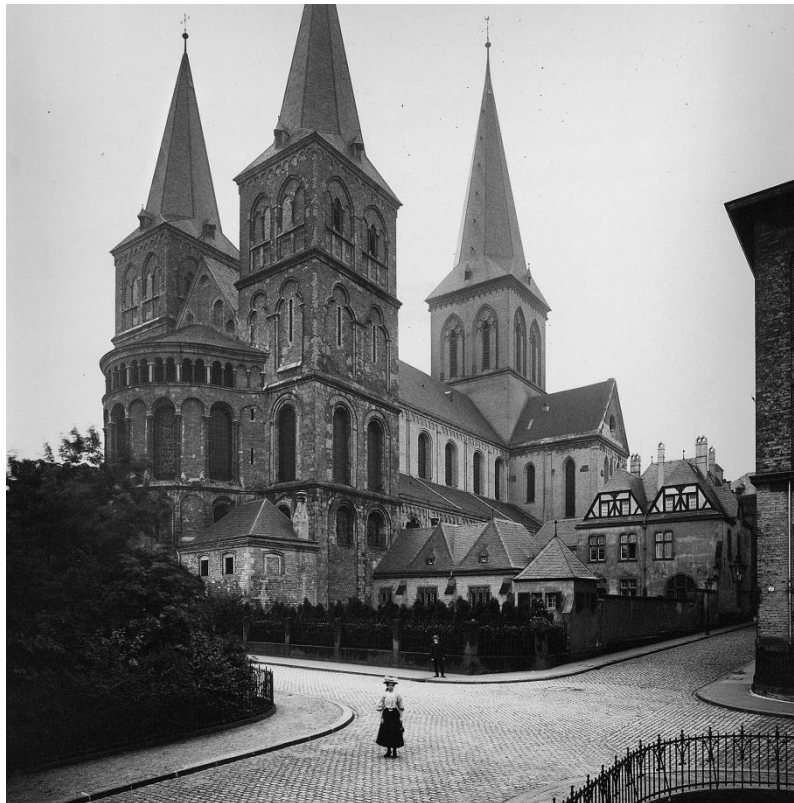
Abb. 143 St. Kunibert von Nordosten, nach 1905. Im Vordergrund die an der Uferstraße vorgelagerten öffentlichen Grünflächen. Neben der Kirche die Gemeindeneubauten, vorne die Sakristei, rechts im Hintergrund das Pfarrhaus. Quelle: Stadt Köln, Konservator
