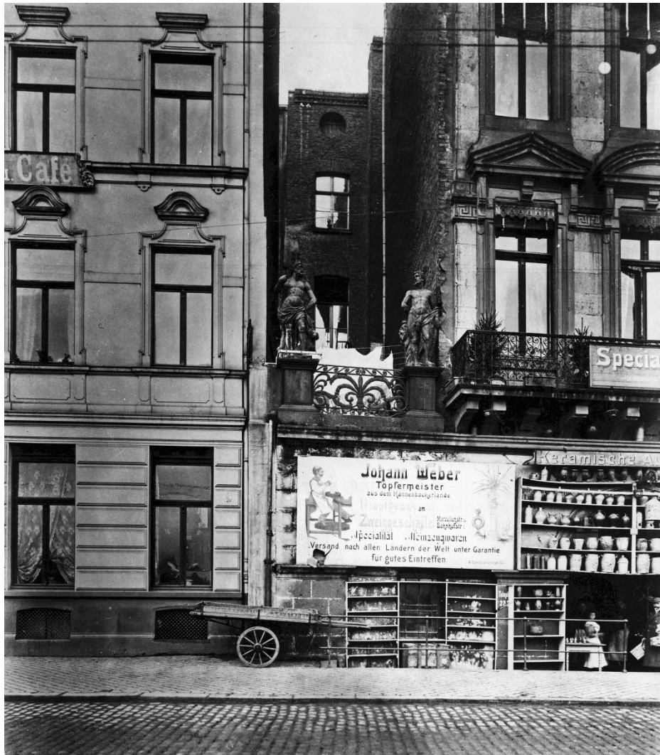
Abb. 39 Die Steinguthandlung Johann Weber im Untergeschoss des Hauses Thurnmarkt 44- an der Leystapelfront (später Leystapel 51) nach der Höherlegung des Leystapels. Quelle: RBA
