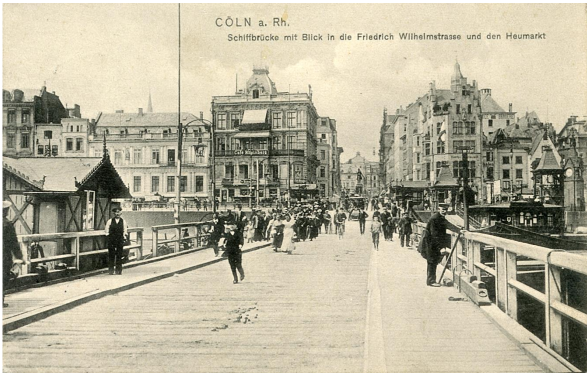
Abb. 43 Postkarte mit Blick von der Schifflücke nach Westen in die Friedrich-Wilhelm-Straße. Links der 1888 fertiggestellte Eckbau des Café Rheinberg; rechts der 1904 errichtete Neubau Friedrich-Wilhelm-Straße 15 an der Ecke zur Hafengasse (Frankenwerft).
