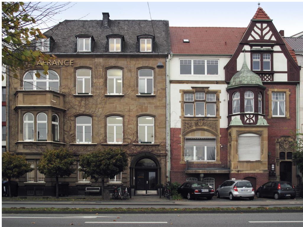
Abb. 132 Die erhaltenen Wohnbauten am Konrad-Adenauer-Ufer 71 (links) und 73 (rechts), ehemals Kaiser-Friedrich-Ufer 71 und 73, im Jahre 2013. Die ursprünglichen Dächer sind heute verändert. Quelle: Fotografie der Verfasserin
