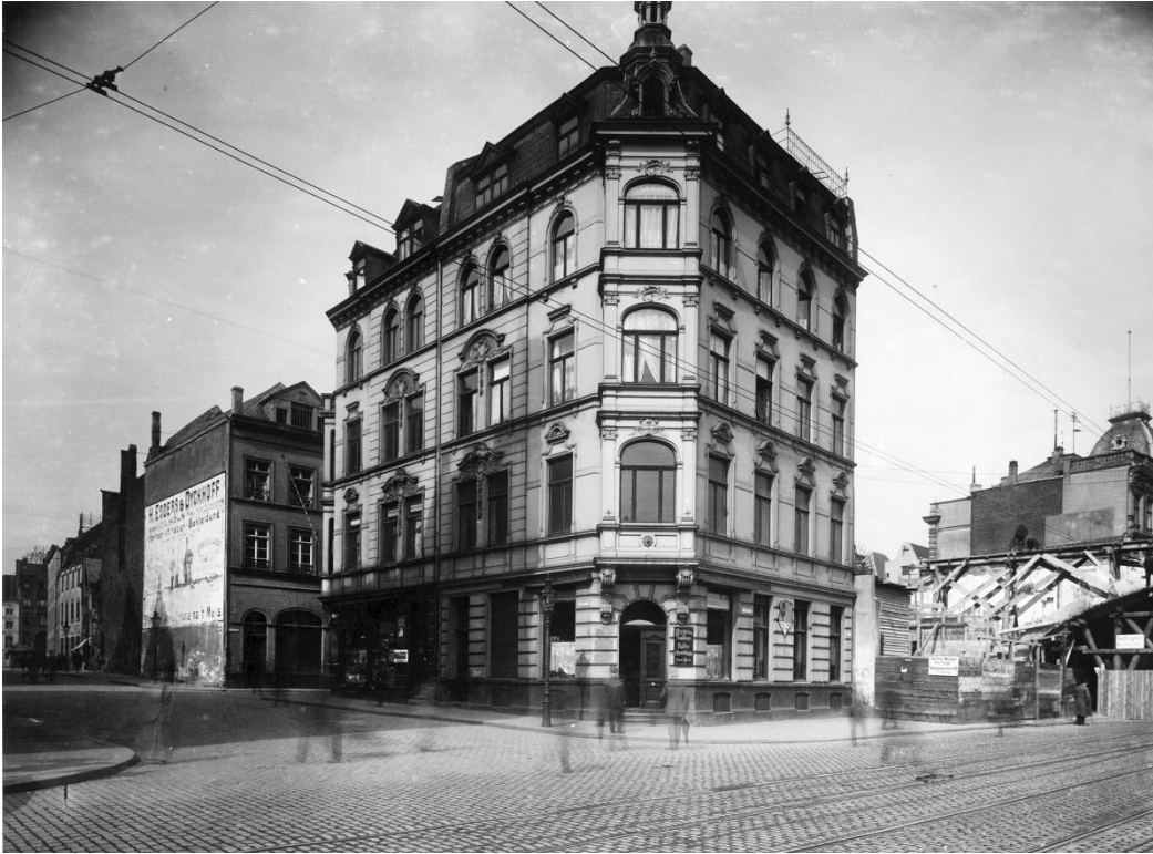
Abb. 92 Die im Jahre 1900 errichteten Neubauten Sassenhof 23 und 25 von Südosten im Jahre 1914. Im Vordergrund der Leystapel, links die Einmündung des Sassenhofs in die Uferstraße. Zu diesem Zeitpunkt sind die Nachbarbauten am Leystapel bereits niedergelegt, um Platz für die im Zuge der städtischen Straßenbrücke erforderliche Rampe zu schaffen. Rechts erkennbar die Arbeiten zum Bau der Überbrückung des Leystapels.
