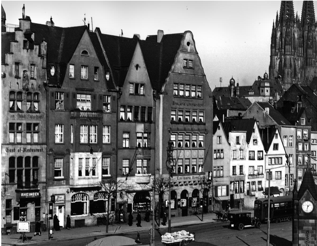
Abb. 115 Blick von der städtischen Straßenbrücke (heute Deutzer Brücke) nach Nordwesten auf die Frankentwerf in den 1920er Jahren. Links die hohen, an die Uferstraße herantretenden Neubauten Friedrich-Wilhelm-Straße 15 sowie Frankentwerf 1, 3 und 5. Rechts daneben die niedrigen Altbauten an der ehemaligen Hafengasse. Quelle: RBA
