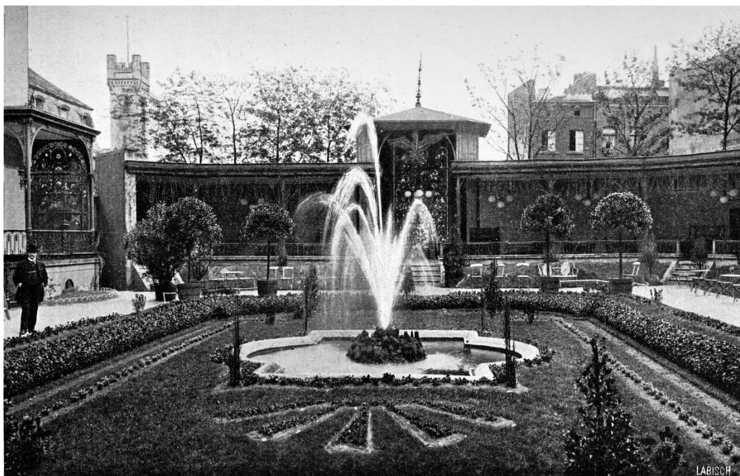
Abb. 125 Blick über den Garten des Hotel du Nord nach Osten im Jahre 1905. Im Hintergrund links einer der linksrheinischen Portaltürme der Dombrücke, rechts die an der Straße Auf dem Brand verbliebenen Wohnbauten. Quelle: Hotel du Nord 1905
