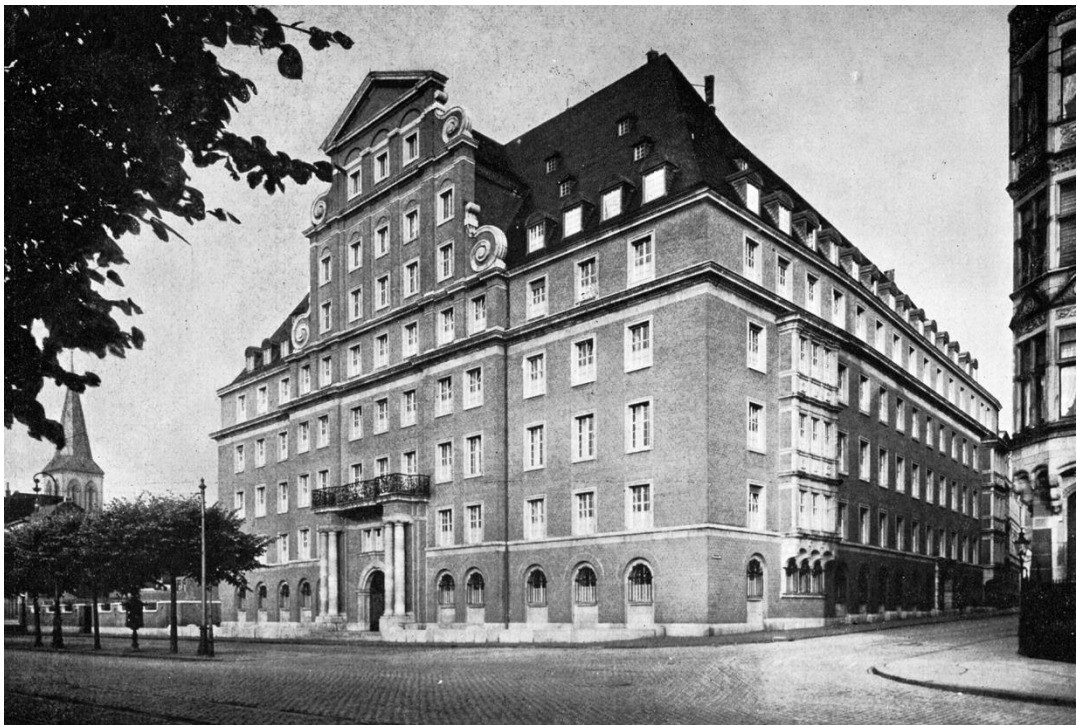
Abb. 157 Verwaltungsgebäude der Rheinischen Aktiengesellschaft für Braunkohlenbergbau und Brikettfabrikation, Kaiser-Friedrich-Ufer 55-61. Der im Jahre 1922 nach einigen Änderungen des Wettbewerbsentwurfs von 1914 fertiggestellte Neubau von Nordosten. Quelle: Köln. Bauliche Entwicklung 1927, S. 169
