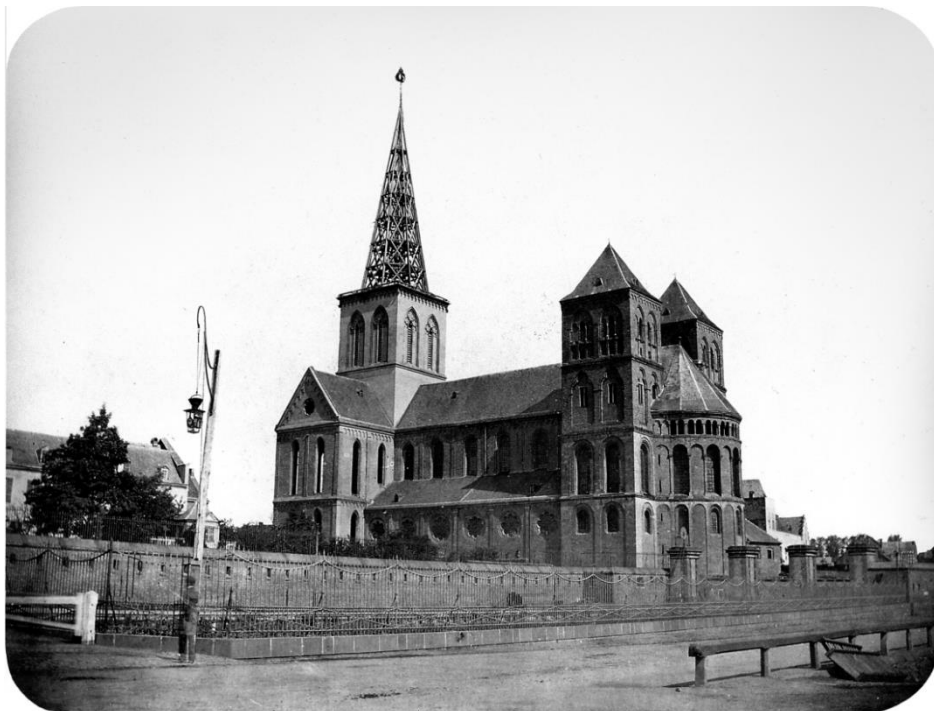
Abb. 29 St. Kunibert von Südosten im Jahre 1859. Fotografie von Johann Jakob Burbach. Hinter der erst wenige Jahre zuvor fertiggestellten Festungsmauer mit den davor verlaufenden Schienen sind die beiderseits der Kirche noch un bebauten Areale des ehemaligen Stiftsbezirks zu sehen.
