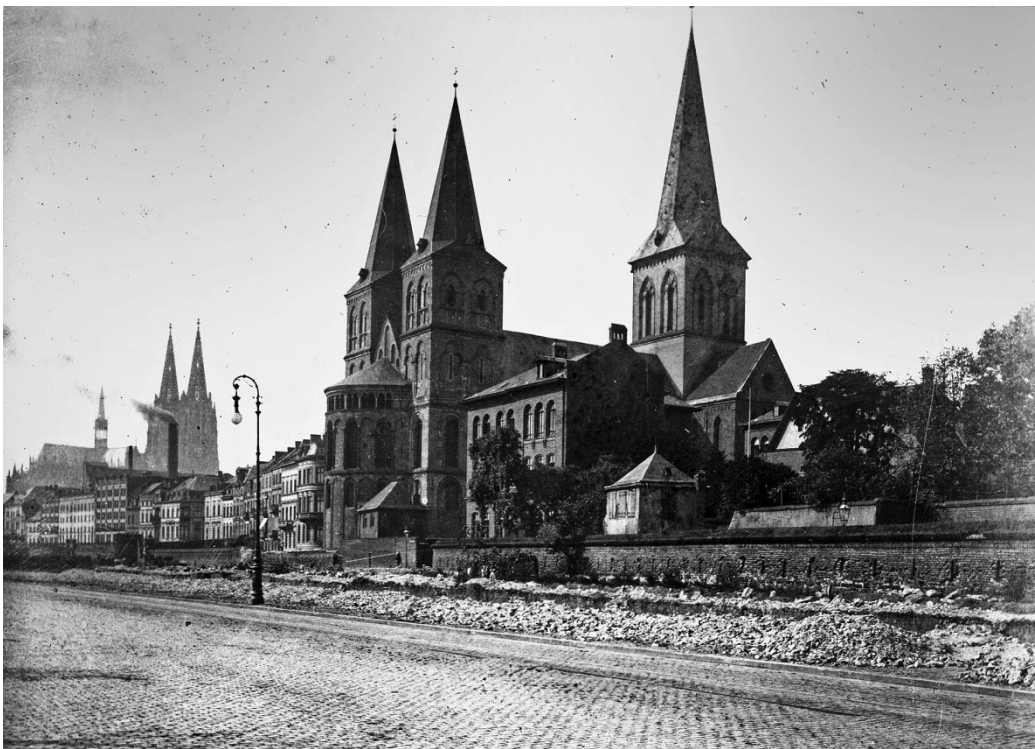
Abb. 71 Das spätere Kaiser-Friedrich-Ufer mit St. Kunibert von Nordosten im Jahre 1898. Die Entfernung der Gleise der Rheinstation ist im Gange, der Abriss der Kehlmauer hat bereits eingesetzt. Quelle: Stadt Köln, Konservator
