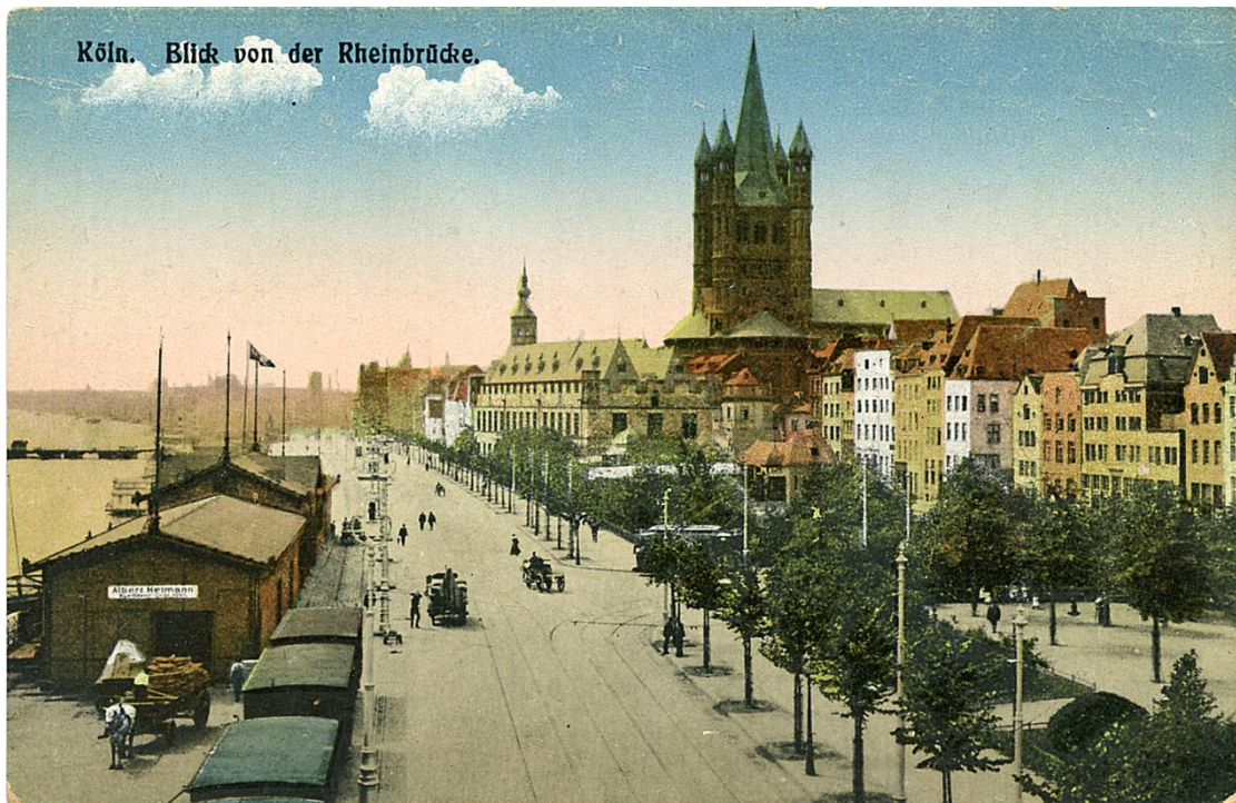
Abb. 73 Postkarte mit Blick auf die Frankenerwerft nach Süden, um 1910. Rechts die Grünanlagen im Norden des Stapelhauses, links die Abfertigungshalle der Niederländischen Dampfschiff-Reederei. Quelle: Archiv der Verfasserin
