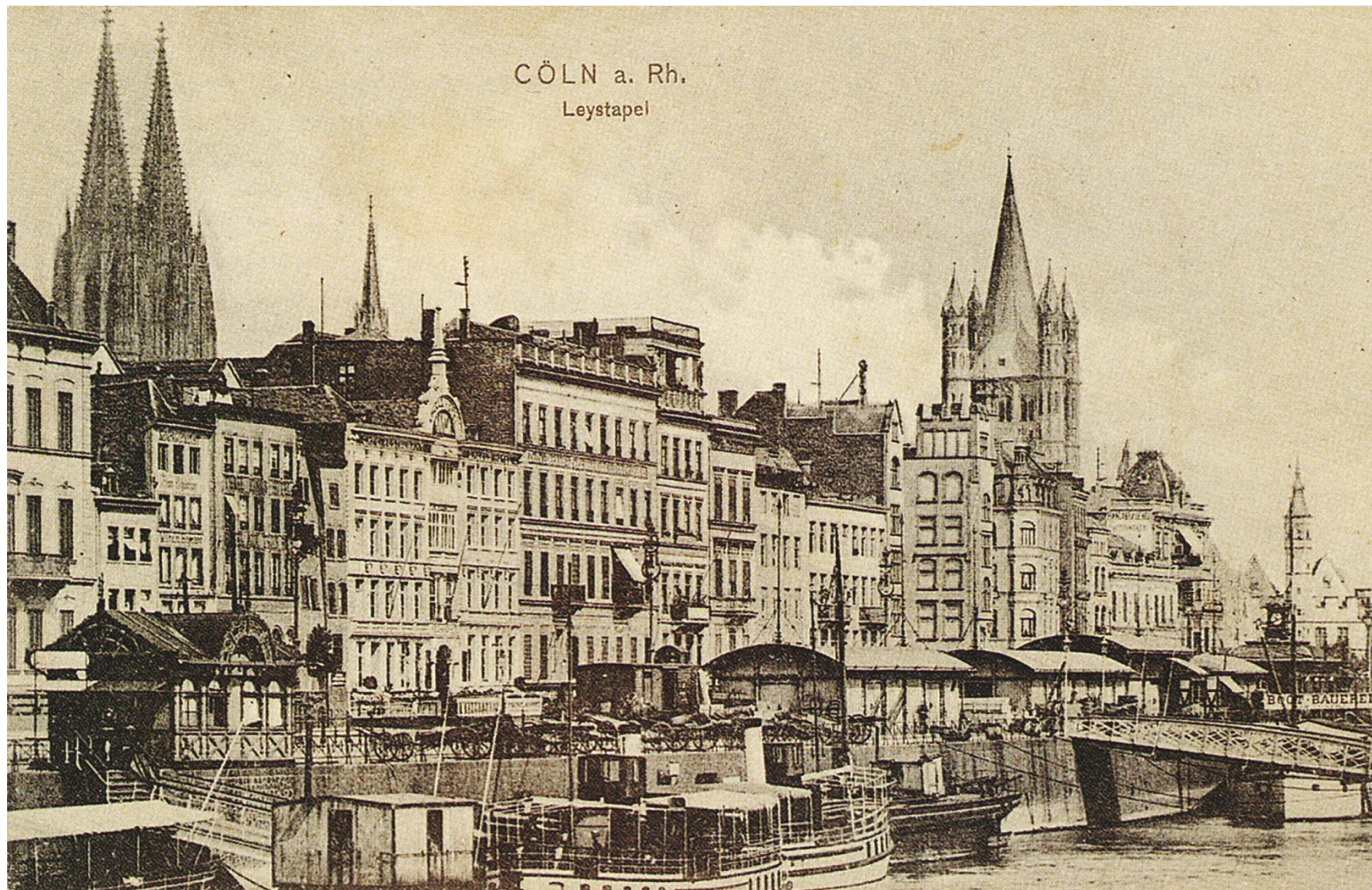
Abb. 41 Postkarte mit Blick auf den Leystapel nach Nordwesten, nach 1908. An der Werft die Aufbauten und Landungsstellen der Schiffahrtsgesellschaften. Links angeschnitten das Eckhaus Thurnmarkt 4 an der Ecke zur Rheingasse; rechts im Hintergrund das Stapelhaus an der Frankenwerft nach seiner Sanierung. Quelle: Sammlung Peter Ditgen
