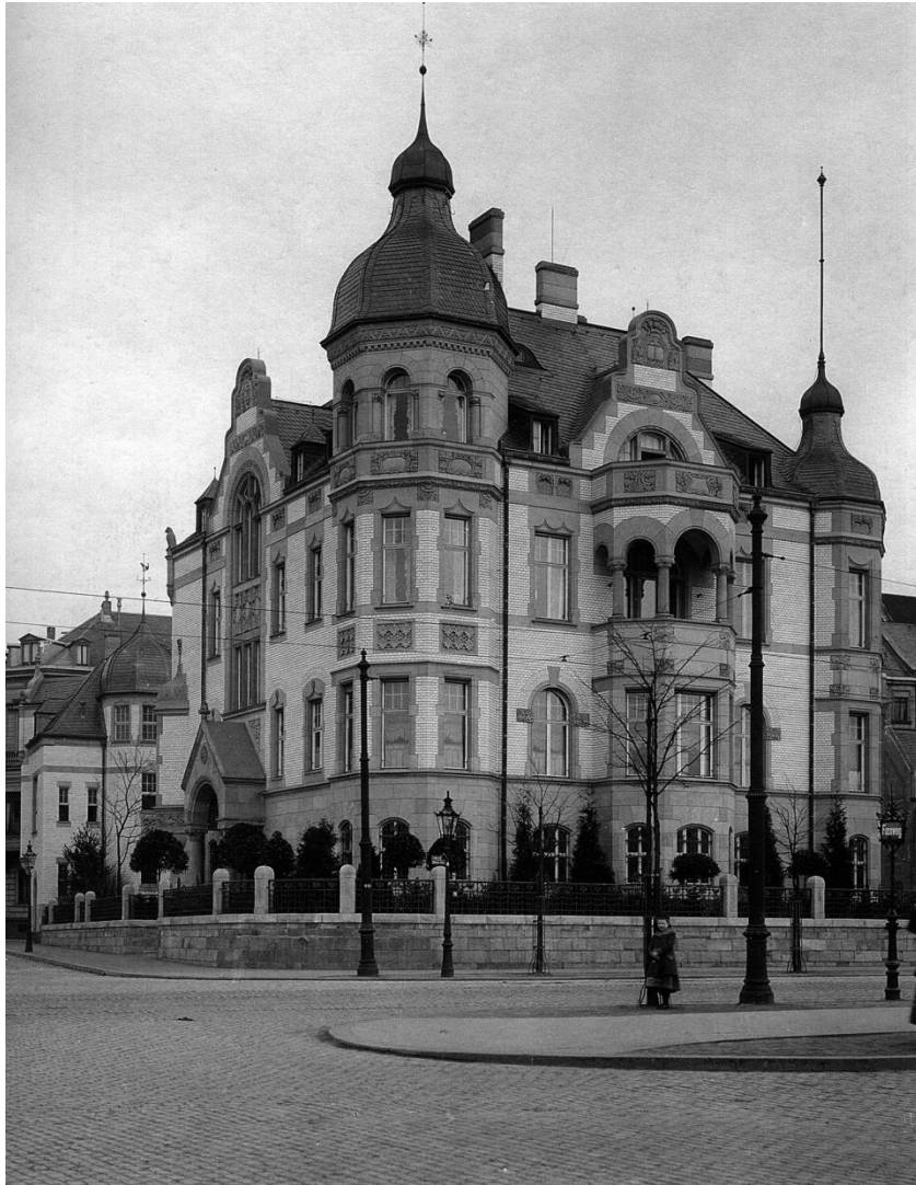
Abb. 136 Die Villa Engelbert Kayser am Kaiser-Friedrich-Ufer 21 von Südosten im Jahre 1904. Links die Front an der Machabäerstraße mit dem Haupteingang, dahinter der niedrigere Atelierbau an der Ecke Machabäerstraße/Kunibertsgasse. Quelle: Dietrich/Wagner 2011, Abb. 42
