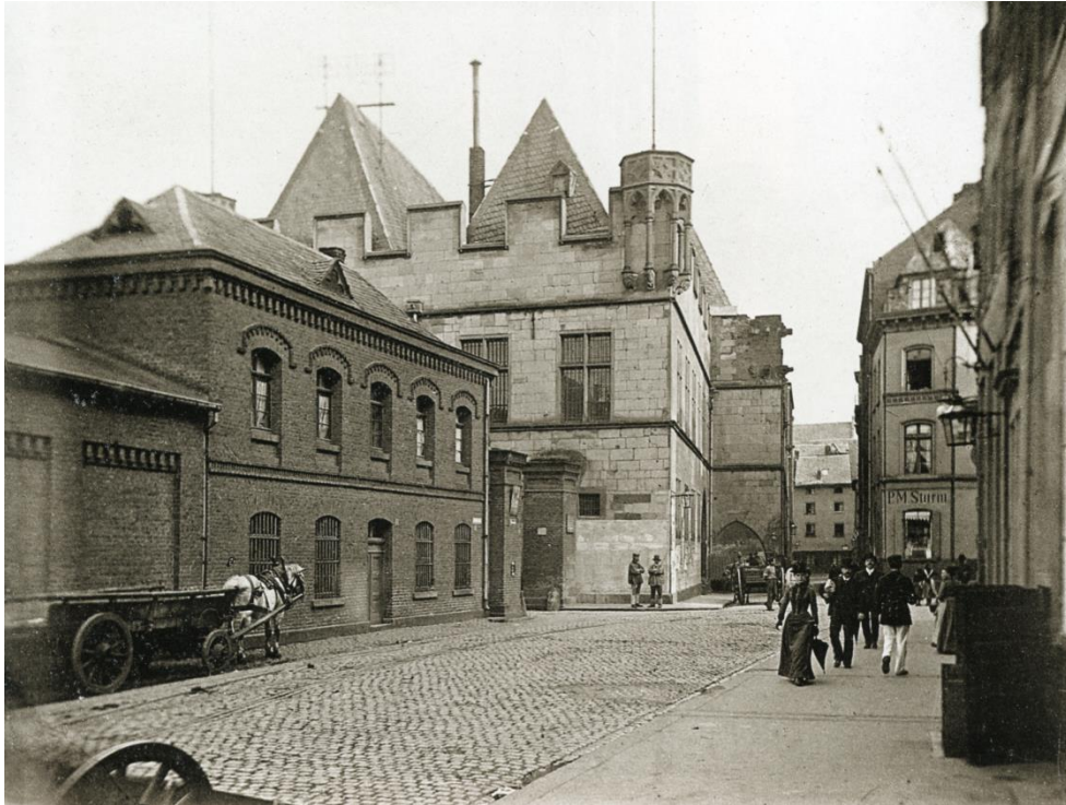
Abb. 10 Blick in die Straße Am Bollwerk nach Süden. Links vorne die Dienstgebäude des Hauptsteueramtes, dahinter das Stapelhaus. Zwischen ihnen ist das Zollhafentor zu erkennen. Fotografie von Wilhelm Scheiner, 1890. Quelle: RBA
