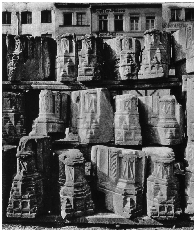
Abb. 109 Altkölnische Fensterpfosten derselben Provenienz, gelagert im Norden des Stapelhauses. Fotografie von Carl Bädecker, 1901. Quelle: Aus dem alten Köln 1900-1908, Tafel IV.18
