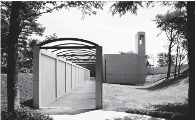
Abb. 7: Tadao Andô: Kapelle des Windes Der Wind-Korridor
