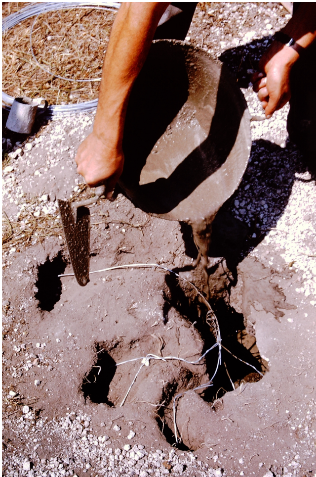
Abb. 11 Sobald die Hohlstelle größtenteils verfüllt ist, kann weiterer Gips/Zement beigefügt werden, ohne eine Beschädigung der Wurzelhöhle befürchten zu müssen, I 11 10, Pompeji.
