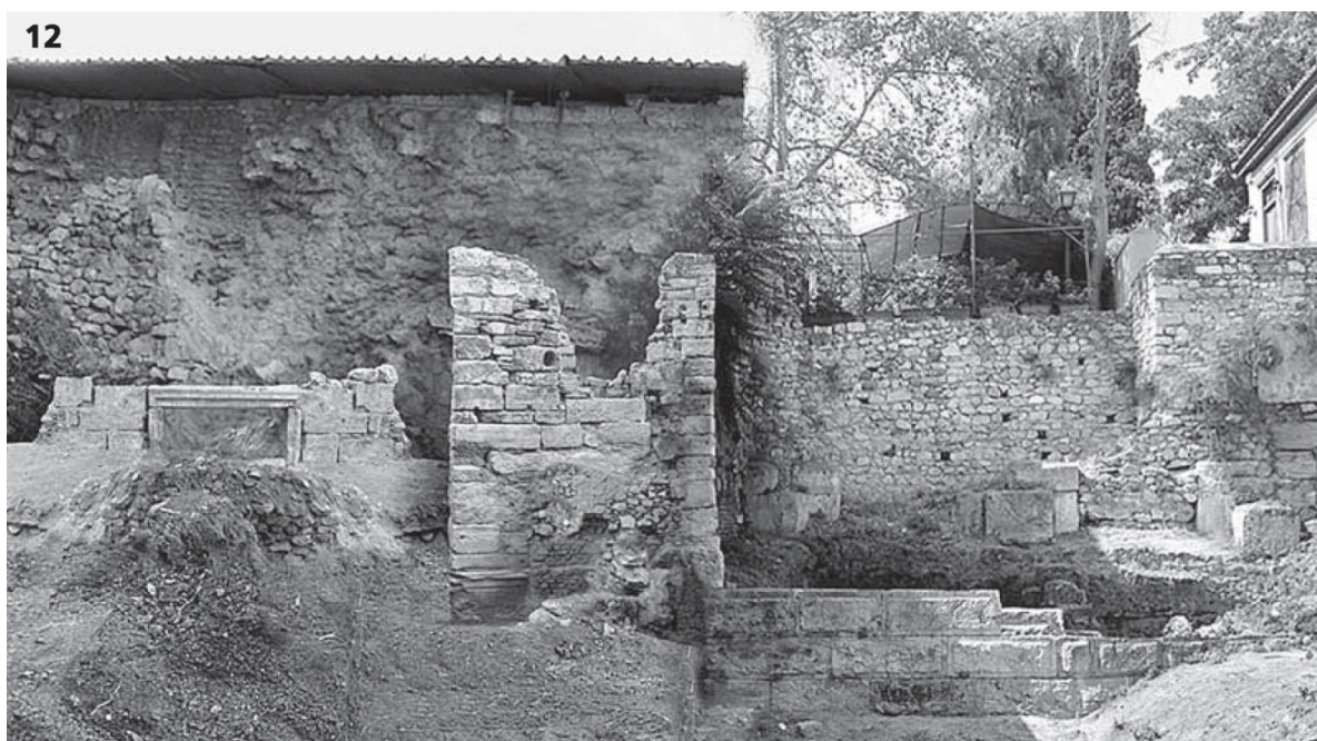
3 Cinta cd post-erula, fianco settentrionale, tratto murario, torre e porta in O. Adrianou 78-80, in basso a destra i blocchi appartenenti al cd. Pantheon adrianeo
