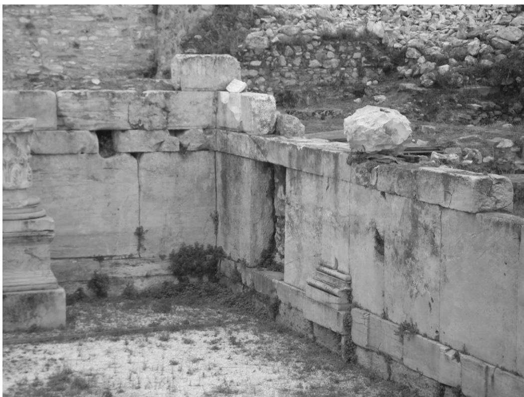
1 Angolo sud-occidentale della Biblioteca di Adriano. Tratto del muro cd. post-erulo, che si salda all'anta meridionale della biblioteca
