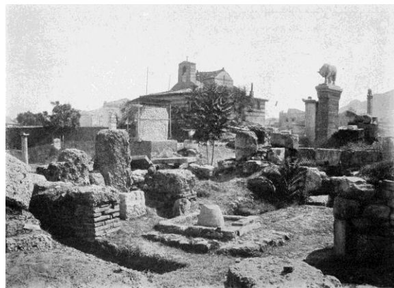
3 La nicchia lungo il lato settentrionale del santuario cd. di Ecate, con all'interno la base di statua e di fronte ad essa la tavola per offerte
