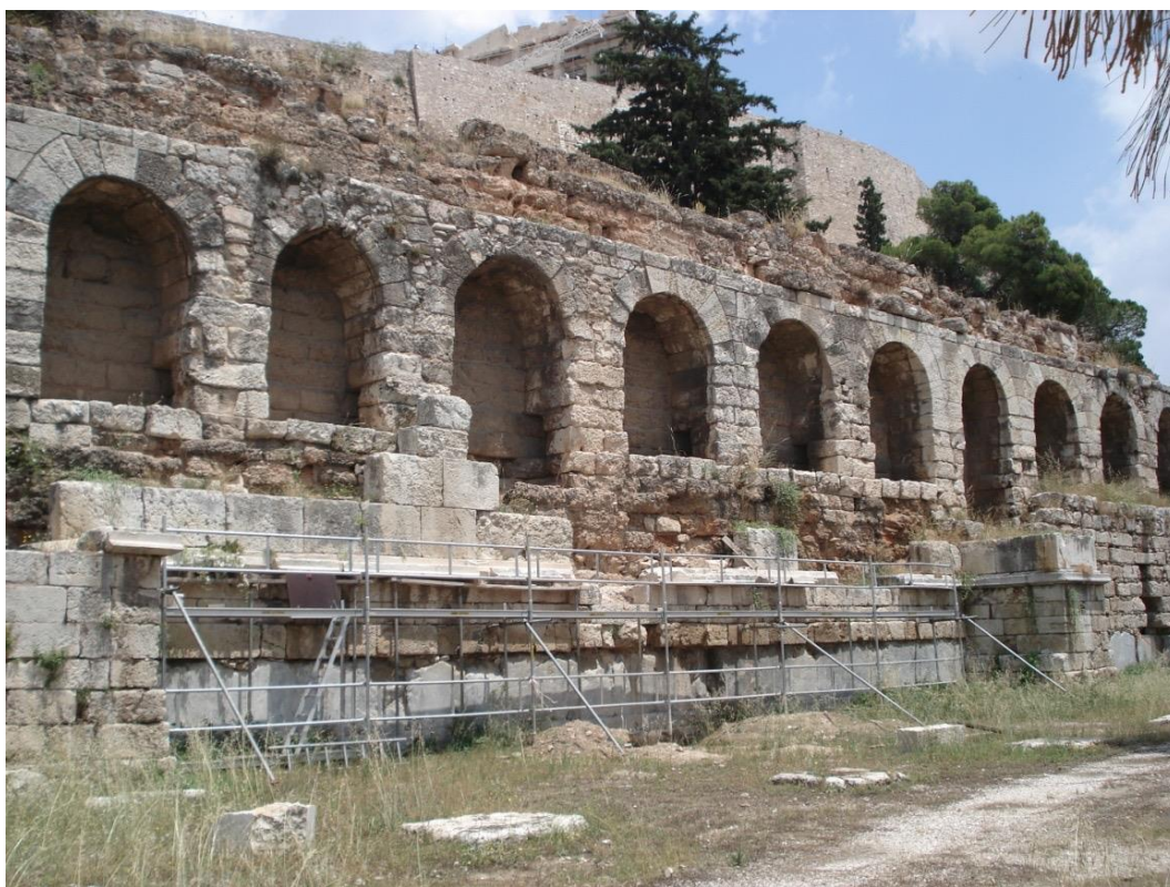
2 Stoa di Eumene, il muro con le arcate e il muro di fondo della stoa a cui si addossano due pilastri attribuiti all'età tardo antica
