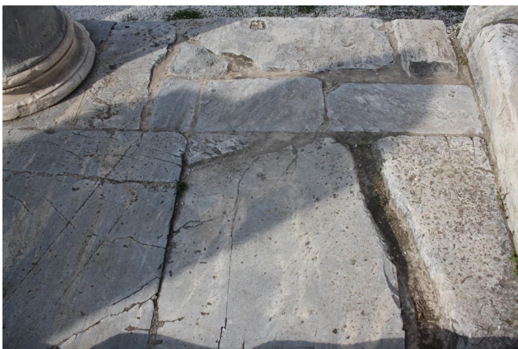
2 Agora romana, il Propylon orientale, canale di drenaggio intagliato nel passaggio settentrionale
