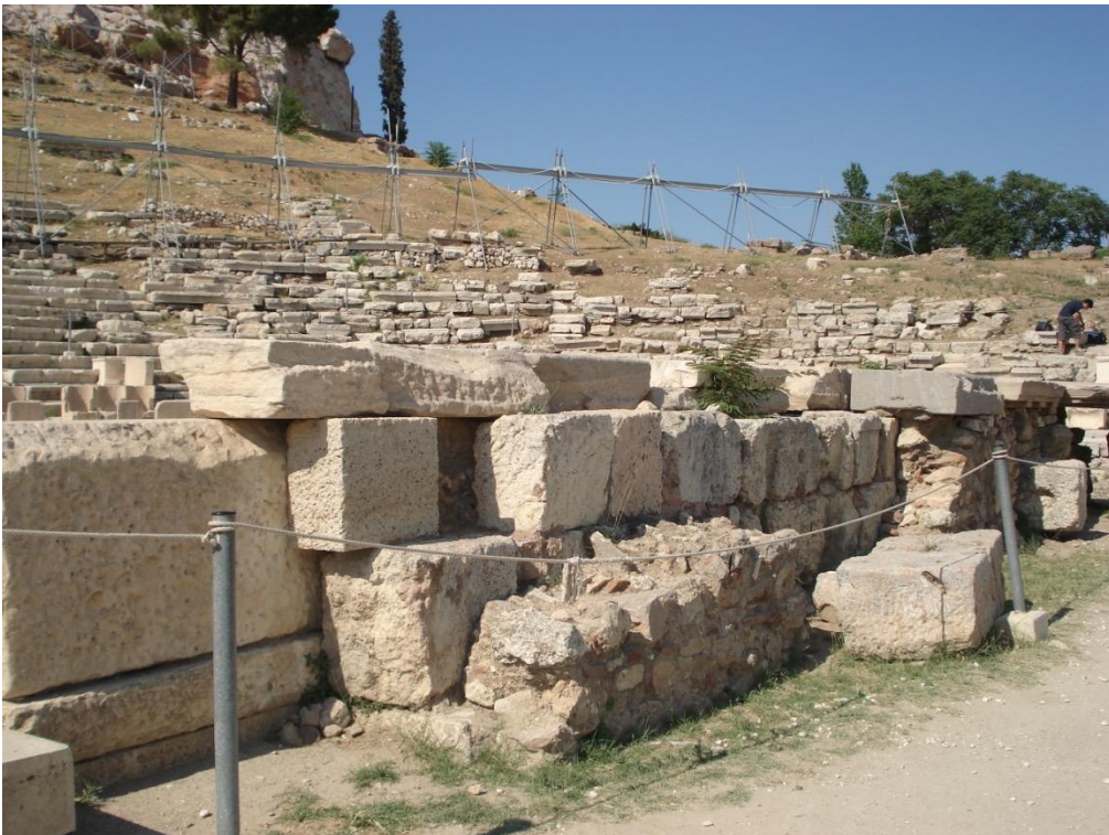
2 Teatro di Dioniso, bema di Fedro, retro della tribuna. Sono visibili il muro in blocchi di poros preesistente, che fu rivestito sul davanti con i rilievi e il muretto in pietrame e malta idraulica costruito contro di esso
