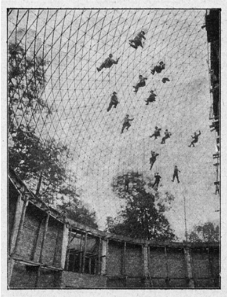
4 Die Netzwerkkuppel des Berliner Planetariums vor dem Auftragen der Betondecke
