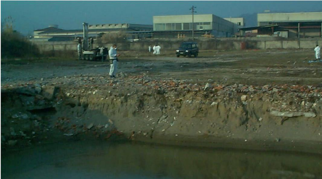
**Abbildung 4.14:** Foto der italienischen Testfläche während der NORISC-Untersuchung. Die Blickrichtung ist Nord-Nord-Ost. Die Baugrube im Vordergrund liegt am Rande der Testfläche. Der Grundwasserspiegel liegt bei ca. 1,5 m unter GOK. Deutlich erkennbar sind Fundamentreste an der Kante der Grube, Auffüllungen und Schutt an der Oberfläche und darunter eine sandige Matrix mit tonigen und kiesigen Anteilen.
