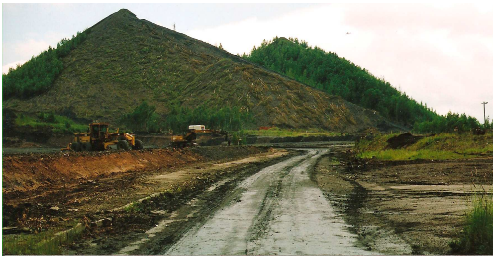
Abb. 54 Beginn der Abtragungsarbeiten im Jahr 2005
