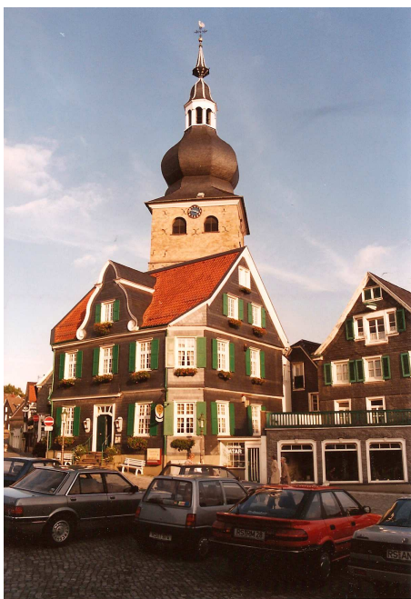
Abb. 26 Schieferverkleidung im Bergischen Land (Lennep)
