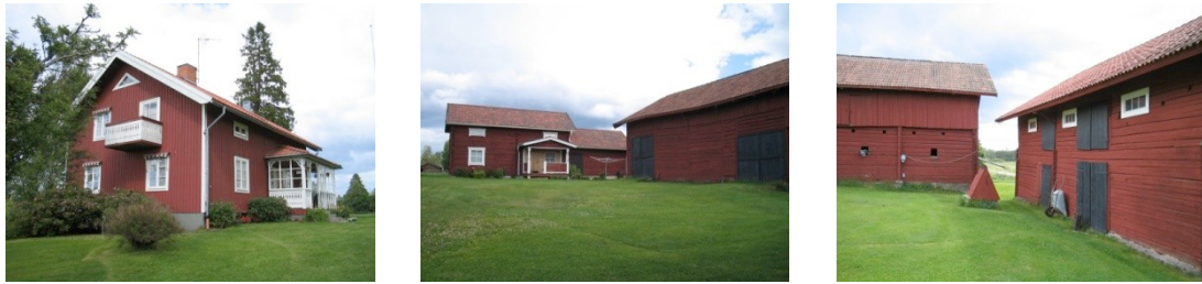
Der Tipersgård ist im Vierkant angelegt. Hof im Juli 2004 (Quelle: Aufnahme der Verfasserin. Nås Juli 2004.)
