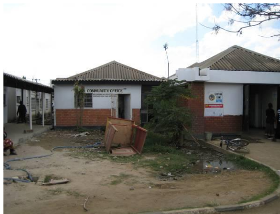
Abb. 11 Renovierungsarbeiten Health Centre Foto: Annabelle Springer 2008
