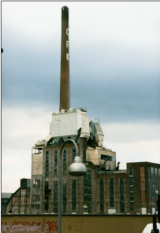
Abb. 39: Fabrikgebäude der CFK bei Abrißarbeiten 1996
