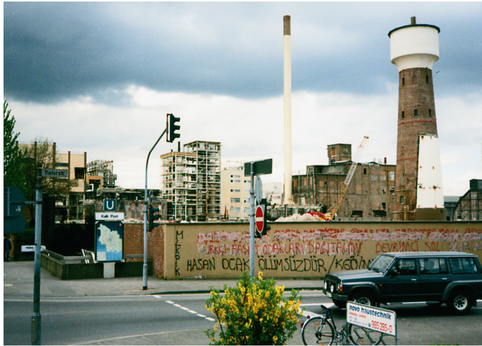
Abb. 11: Chemische Fabrik Kalk, Abbrucharbeiten 1996, Ansicht, Straßenkreuzung Kalker Hauptstraße/Vietorstraße. (Foto: T. Libor-Dörstel 1996)
