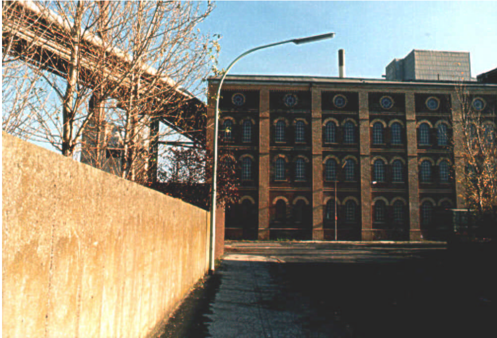
Abb. 20: CFK-Gebäude in der Eisenbahnstraße, Backsteinfassade rot mit Verzierung (Foto: T. Libor-Dörstel 1996)
