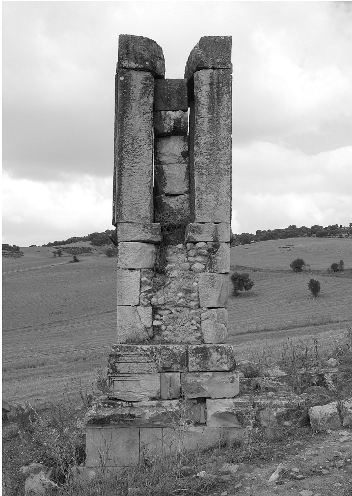
Abb. 17: Partieller opus caementicium-Kern, Südliches Bogenmonument in Uchi Maius
