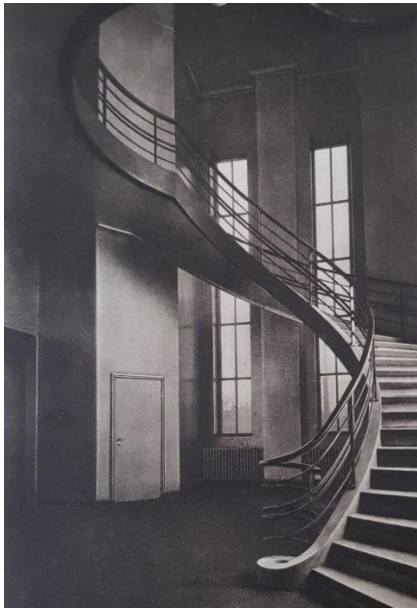
Abb. 148: Die Eingangshalle (Erdgeschoss) des PRESSA-Turms, nach: PRESSA-Katalog, Abb. S. 29 (Fotograf*in: unbek.).
