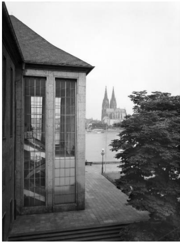
Abb. 118: Der südliche Kopfanbau der Kaserne von Adolf Abel und Blick auf den Dom, nach: RBA, Nr. 54852 (Fotograf*in: unbek.); URL: https://www.kulturelles-erbe-koeln.de/documents/obj/05210363/rba_054852 .
