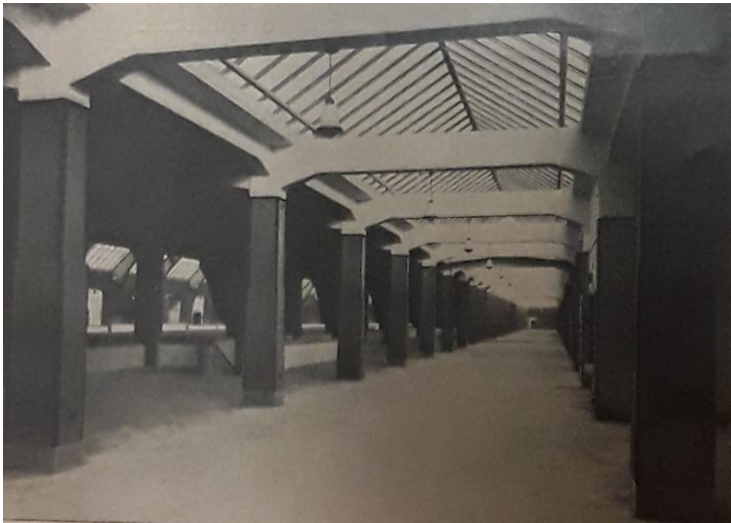
Abb. 36: Blick in das Seitenschiff der Westhalle (Obergeschoss), nach: Wickop 1925, S. 4 (Fotograf*in: unbek.).
