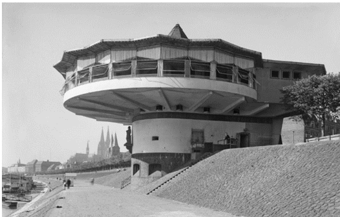
Abb. 125: Das linksrheinische Restaurantgebäude Bastei, Architekt: Wilhelm Riphahn, 1930, nach: RBA, Nr. 36405 (Fotograf*in: unbek.); URL: https://www.kulturelles-erbe-koeln.de/documents/obj/05160140/rba_036405 .
