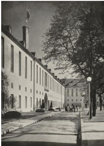
Abb. 121: Blick auf die veränderte Westfassade der Kaserne, nach: Abel 1928a, S. 381 (Fotograf: Hugo Schmölz).
