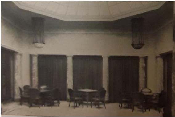
Abb. 53: Der überkuppelte (mittlere) Gesellschaftsraum vor dem Eintritt in die Große Halle, nach: Wickop 1925, S. 12 (Fotograf*in: unbek.).
