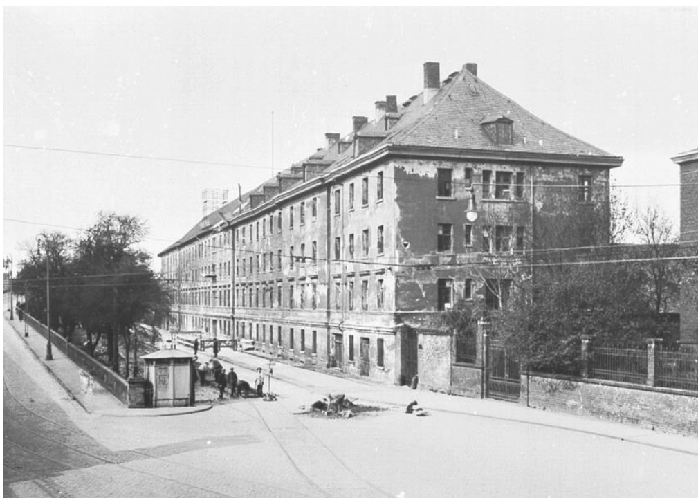
Abb. 115: Die Kürassierkaserne im renovierungsbedürftigen Zustand, 1927, nach: RBA, Nr. 25877 (Fotograf*in: unbek.); URL: https://www.kulturelles-erbe-koeln.de/documents/obj/05210153/rba_mfPL025877 .
