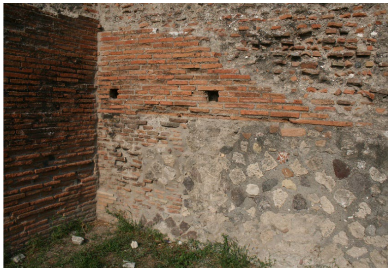
Abb. 49: Nordostecke des Comitiums. Vergleiche die Ziegel der ID OT1 (unten) und OT2 (oben).
