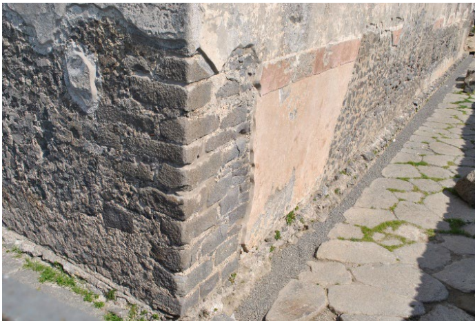
Abb. 45: Nordwestecke der Basilika. Eckverstärkung und opus incertum aus kompakter Lava.
