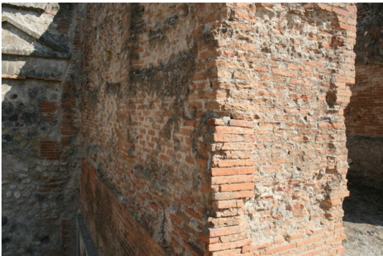
Abb. 190: Mauer I des Tempels d. Genius d. Augustus mit Aushackungen für die Marmorverkleidung.
