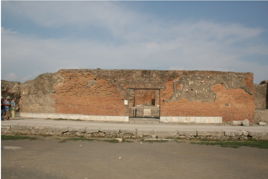
Abb. 181: Fassade A des Tempels des Genius des Augustus.
