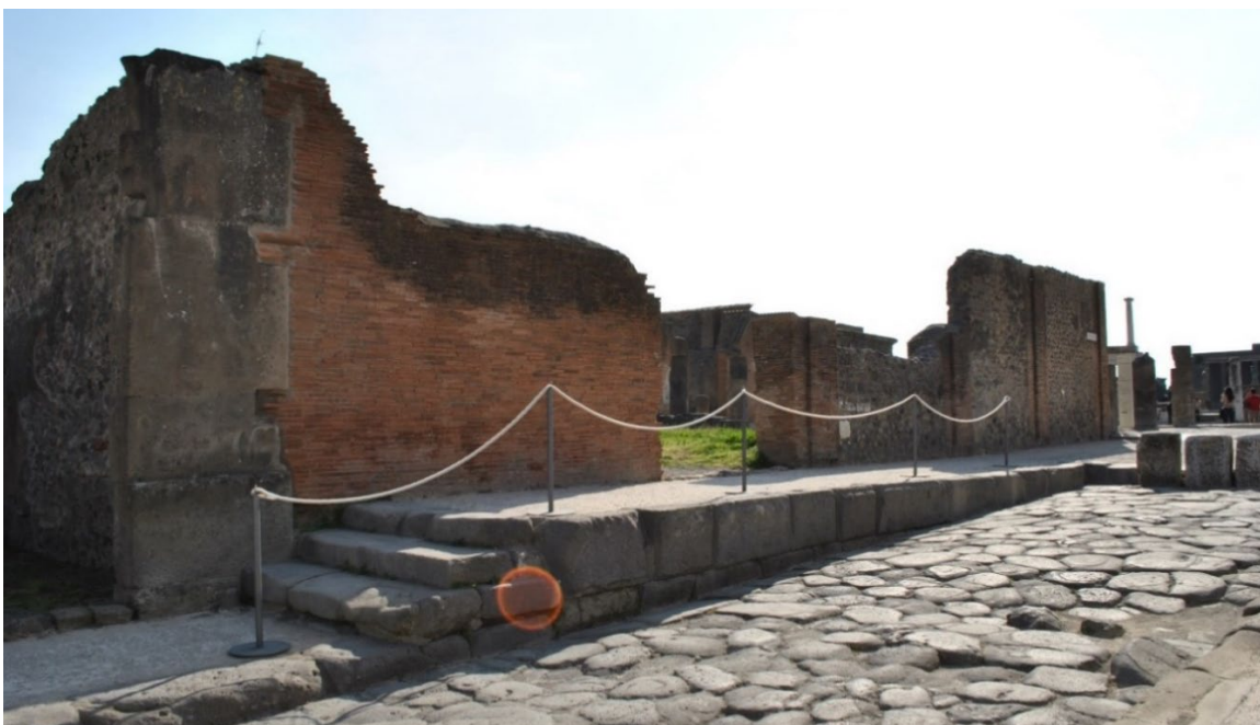
Abb. 50: Außenansicht der Nordfassade A des Comitiums.
