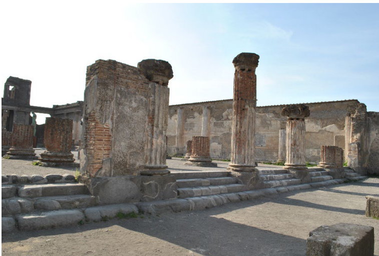
Abb. 43: Eingangsfassade B der Basilika.
