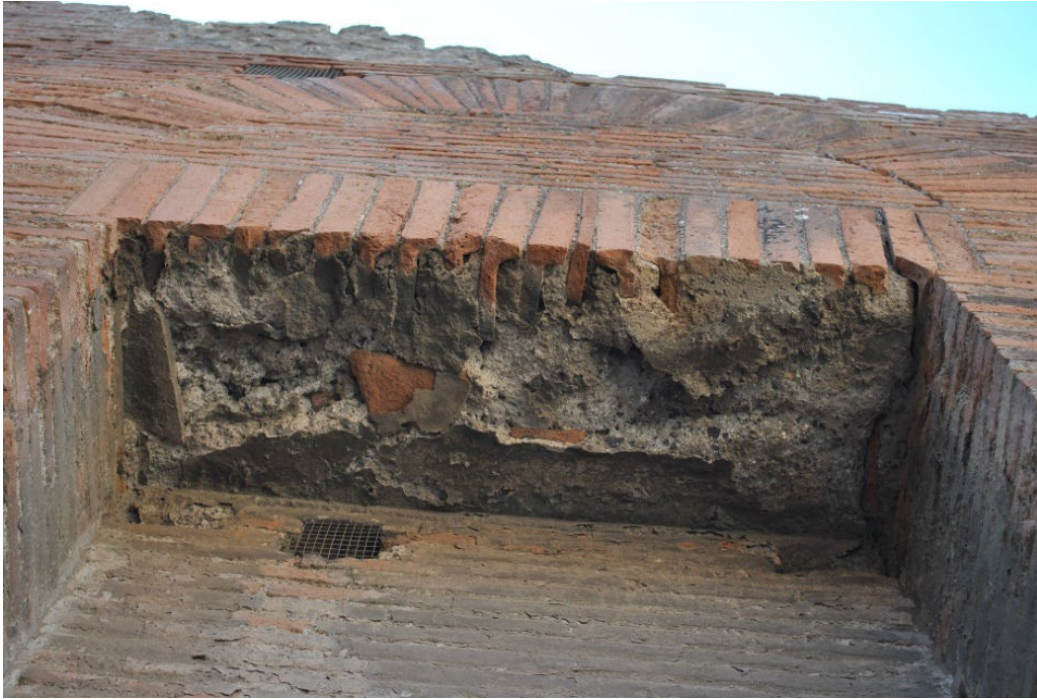
Abb. 28: Typische Verwendung von zerteilten Dachziegeln für die Schale eines scheinrechten Bogens (westl. Amtslokal).
