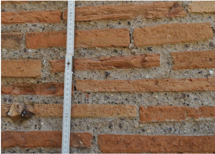
Abb. 30: Mörtelfugen einer Ziegelmauer (Macellum).
