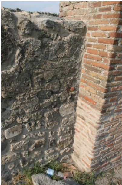
Abb. 48: Detail der Ziegelpfeiler in Nordmauer A des Comitiums.
