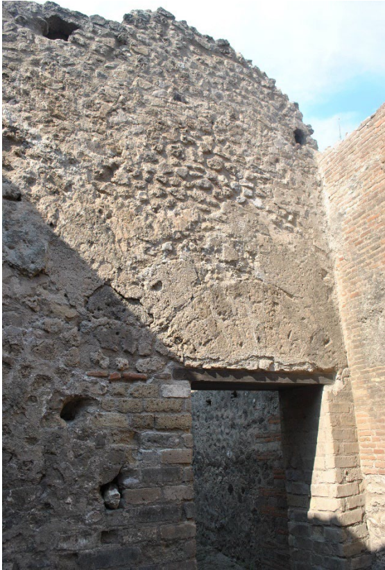
Abb. 116: Zwischenmauer O.2, Nebenräume IV des Gebäudes der Eumachia.
