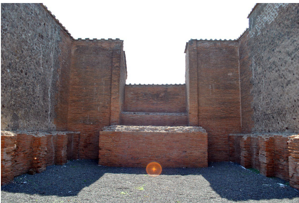
Abb. 73: Nische mit Podest in Südmauer G des zentralen Amtlokals.
