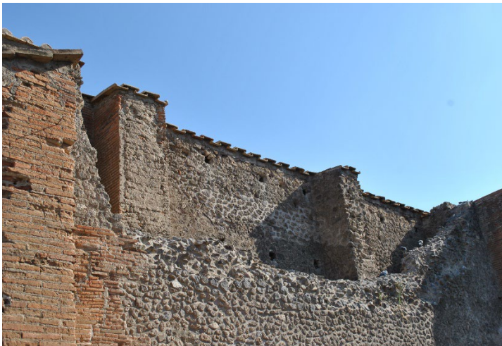
Abb. 67: Zwischenverbände 1 und 2 zwischen östl. und zentralem Amtslokal.
