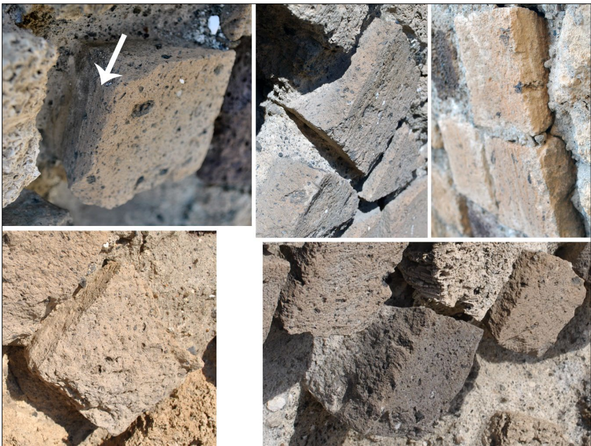
Abb. 9: In Pompeji vermauerte Retikulatsteine mit sichtbaren Werkzeugspuren.
