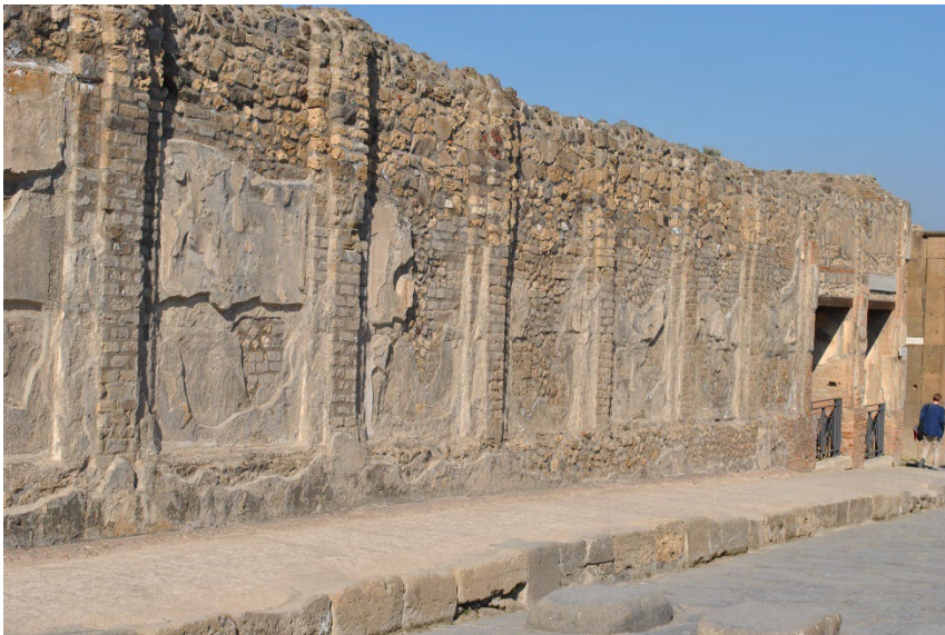
Abb. 108: Mauer E' und Taberne II im Gebäude der Eumachia.
