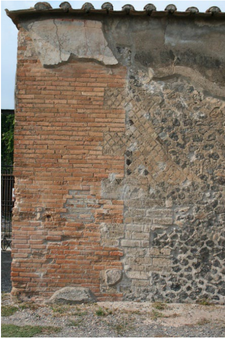
Abb. 98: Detail der Innenschale der Mauer B mit Häufung unterschiedlicher Mauertechniken.
