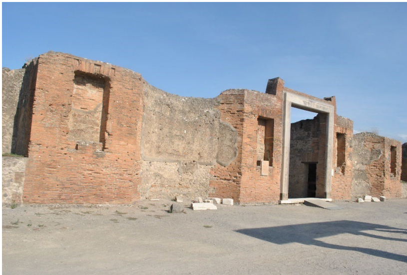
Abb. 105: Abschnitt P.b und Haupteingang des Gebäudes der Eumachia.
