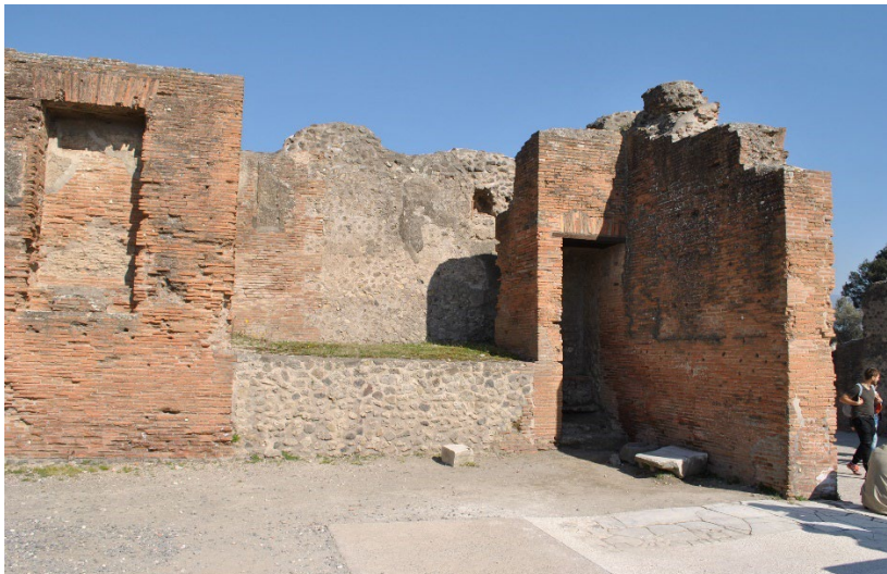
Abb. 106: Exedra P.d in der Fassade des Gebäudes der Eumachia.
