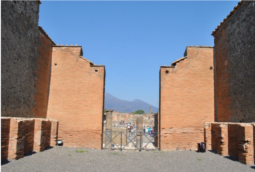
Abb. 71: Nordmauer E des zentralen Amtlokals.
