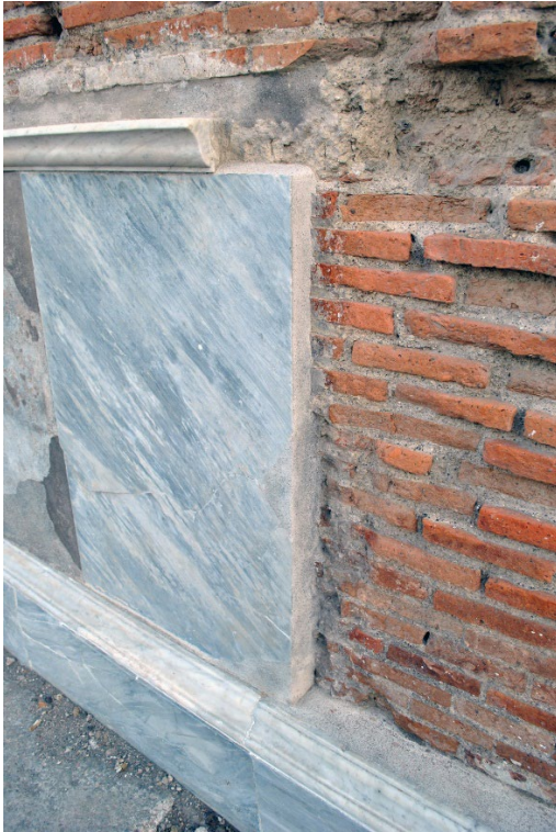
Abb. 25: Profile und Sockelverkleidung der Fassade des östlichen Amtlokals.
