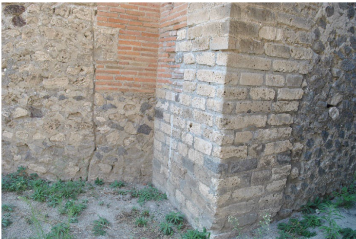
Abb. 61: Äußere Südostecke des östl. Amtslokals. Übergang von C.1 zu C.2.
