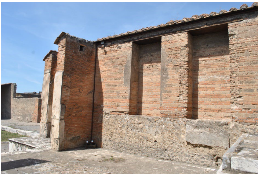
Abb. 94: Nischen in Nebenraum III im Macellum.
