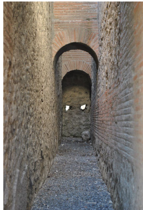
Abb. 68: Gang II zwischen östl. und zentralem Amtslokal.
