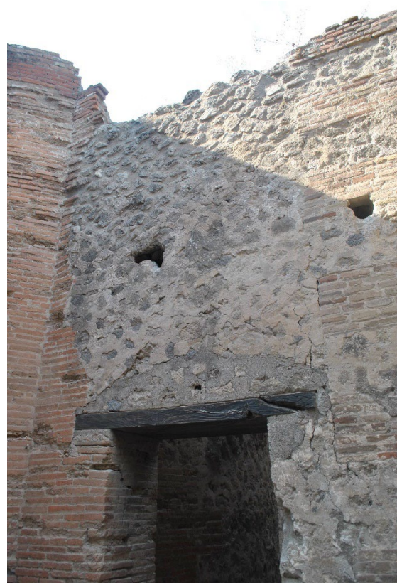
Abb. 117: Zwischenmauer O.3, Nebenräume IV des Gebäudes der Eumachia.
