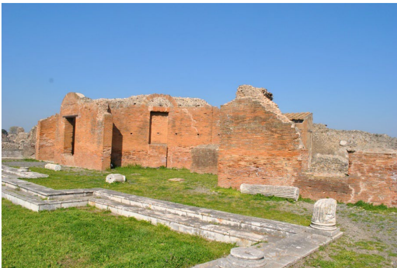
Abb. 115: Mauer J mit sich öffnender Apsis im Gebäude der Eumachia.
