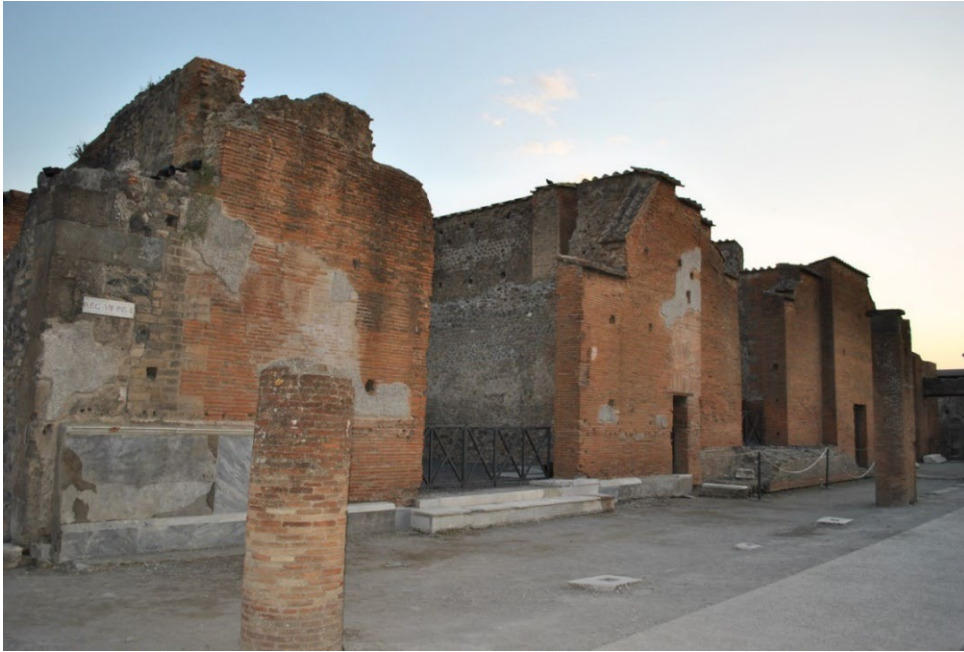
Abb. 59: Fassade der Amtslokale. Vorne im Bild Amtslokal Ost.
