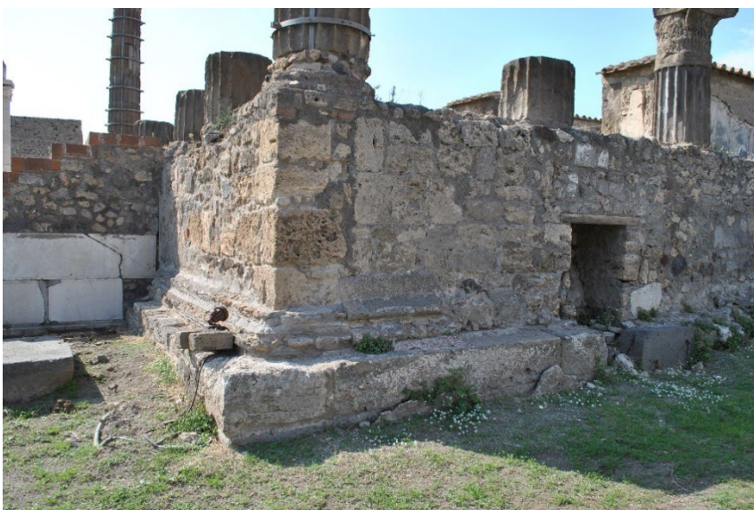
Abb. 135: Südostecke des Podiums des Apollotempels.
