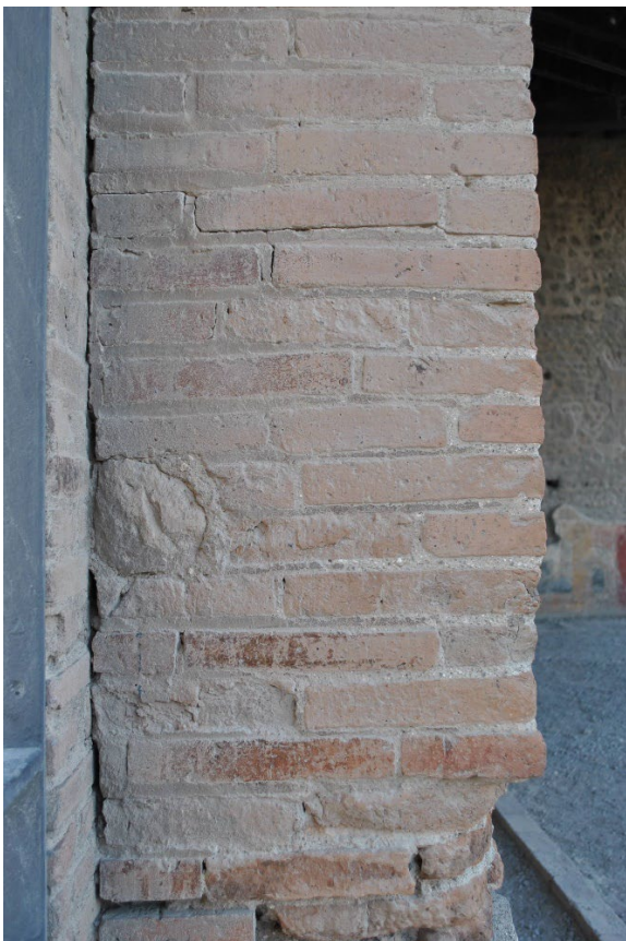
Abb. 87: Übergang der Mauern Y und A des Macellums.
