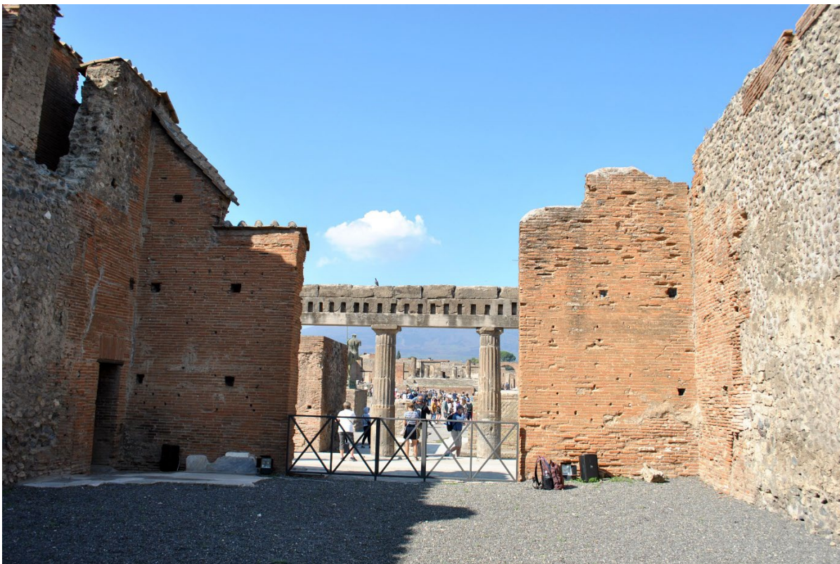
Abb. 64: Nordmauer A des östlichen Amtslokals.
