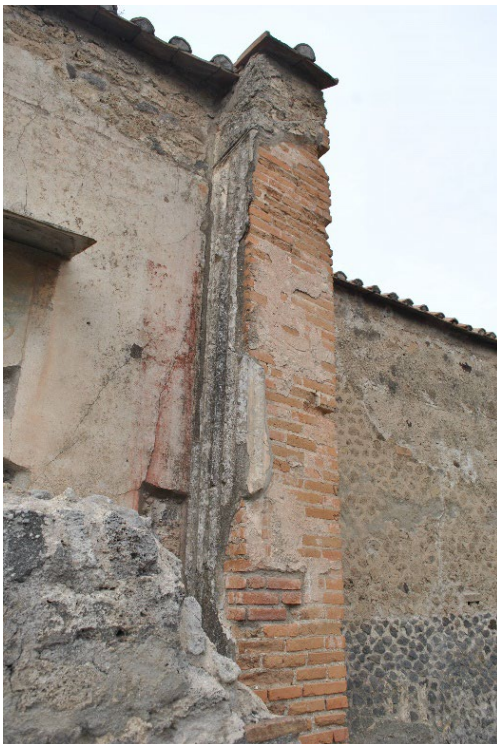
Abb. 103: Ziegelpilaster mit Stuckresten von Schaft und Kapitell am Raum II des Macellums.
