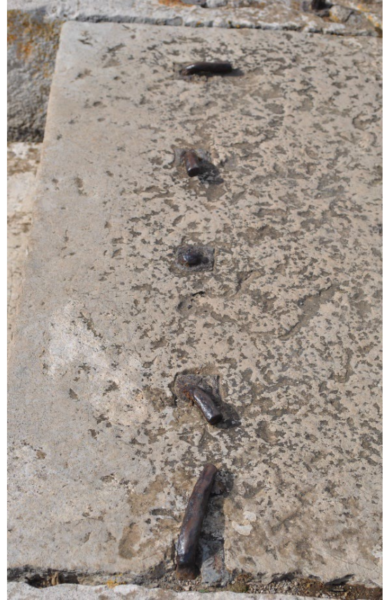
Abb. 159: Überreste des Eisenzauns im Podest des Tempels der Fortuna Augusta.
