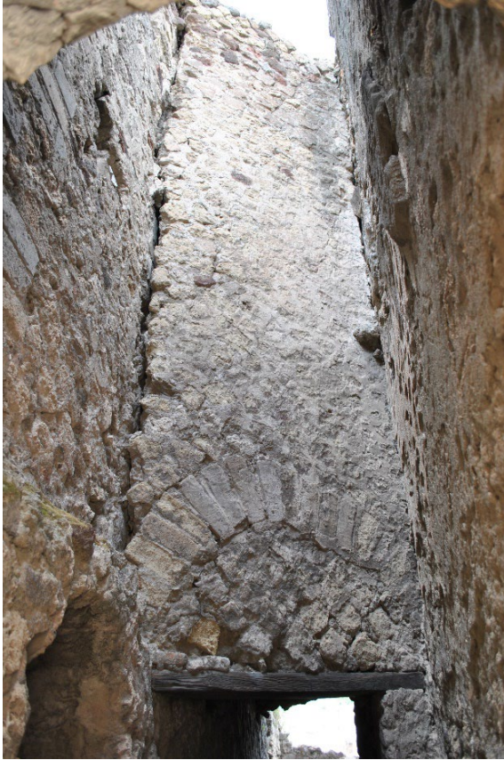
Abb. 158: Rückwärtige Ansicht der Apsis in Mauer C des Tempels der Fortuna Augusta.
