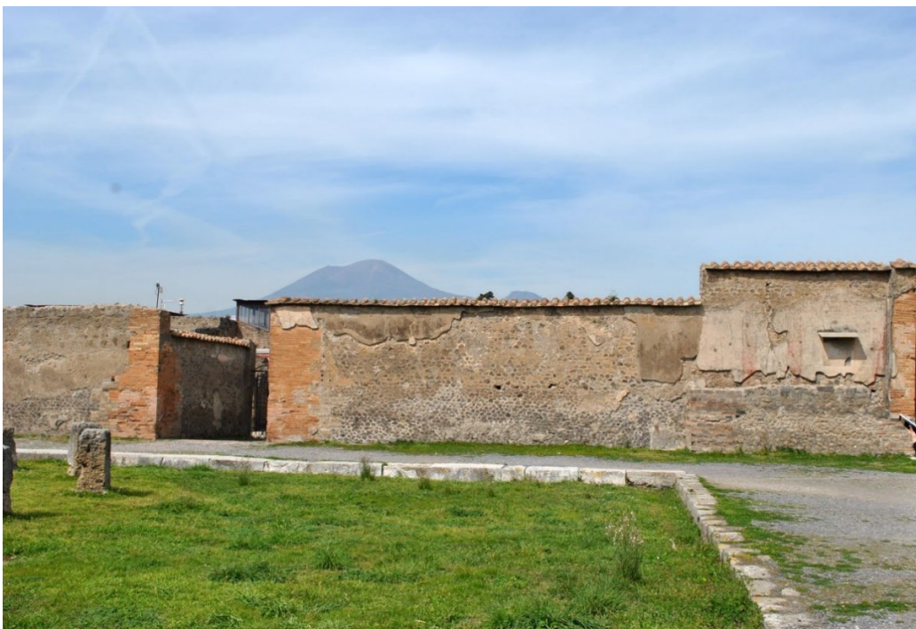
Abb. 97: Nordmauer B der Portikus des Macellums. Davor der Stylobat aus Tuffstein (rechts) und aus weißem Kalkstein (oben).
