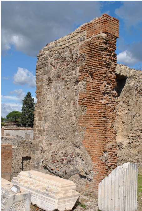
Abb. 162: Westmauer A des Tempels der Fortuna Augusta.
