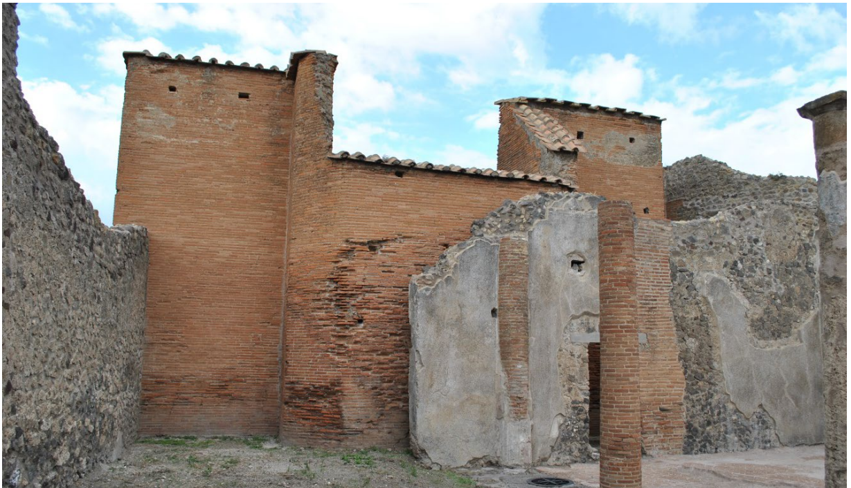
Abb. 70: Außenansicht der Südmauer G des zentralen Amtslokals.
