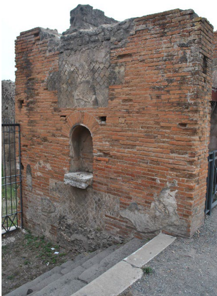
Abb. 91: Seitenwand N des Eingangs in Mauer C des Macellums.
