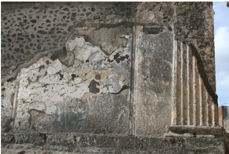
Abb. 142: Eckpilaster an Ostmauer C des Jupitertempels.
