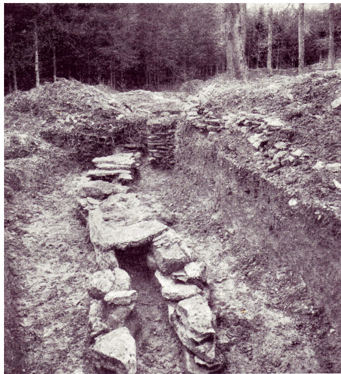
Abb. 17 Kanal vor dem östlichen Nebengebäude von Osten der Villa „Brasil“ in Mayen nach Oelmann 1928 (siehe Katnr. 5.3)
