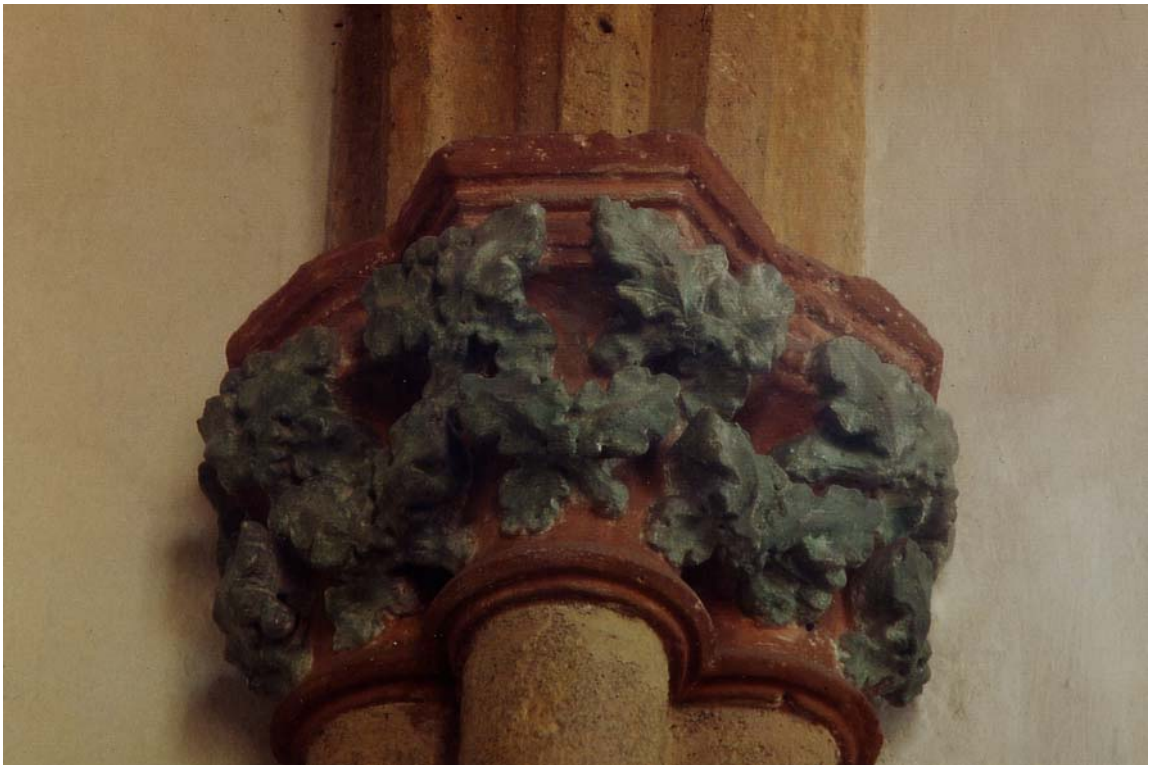
Abb. 197 St. Walpurgis bei St. Michael (St), Filialkirche St. Walpurgis, Chor, Wandvorlage
