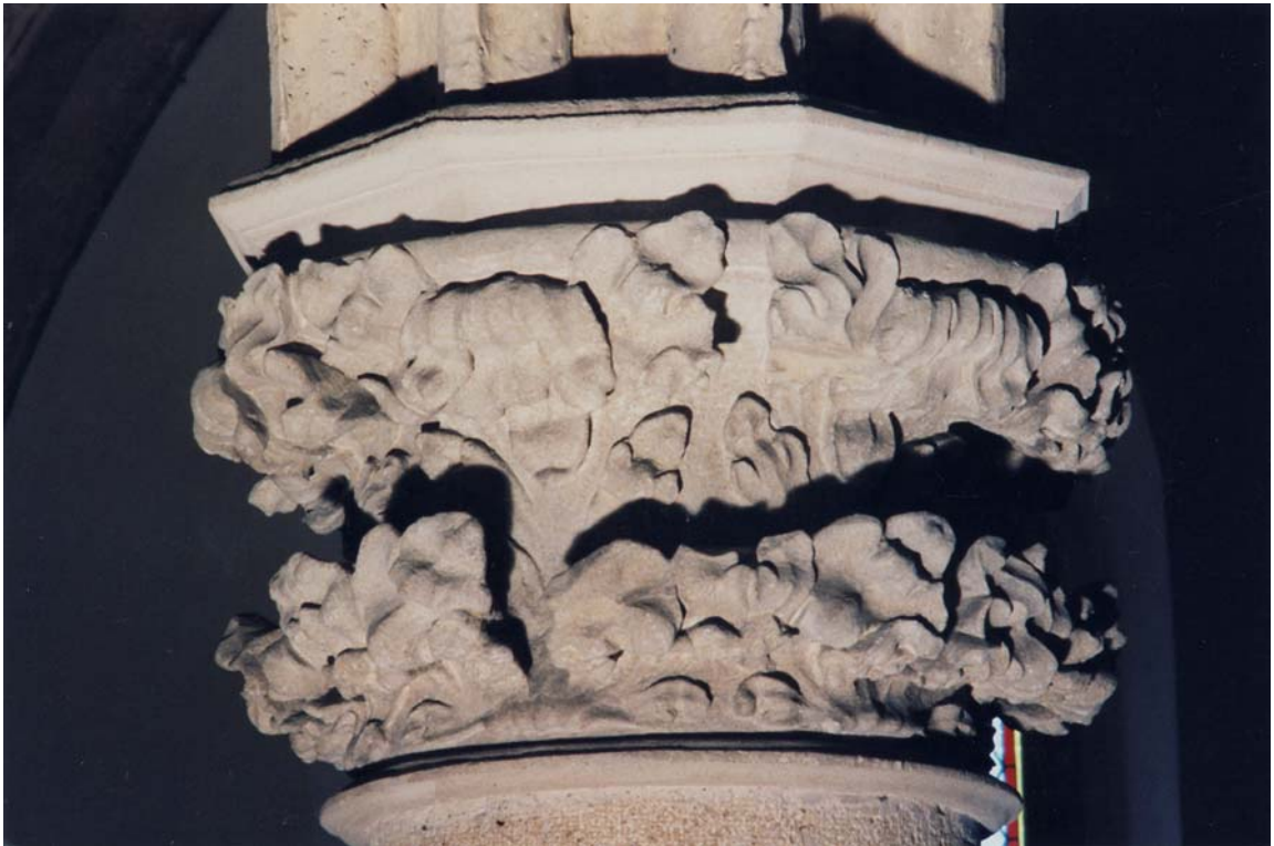
Abb. 112 Neuberg, Klausur, Osttrakt, Kapitelsaal, nordöstliche Stütze, Kapitell KS2
