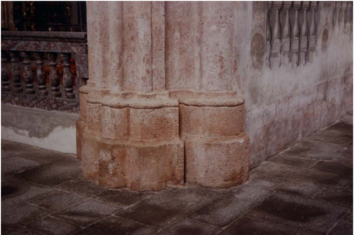
Abb. 44 Neuberg, Klosterkirche, Chor, Pfeilersockel mit Podest
