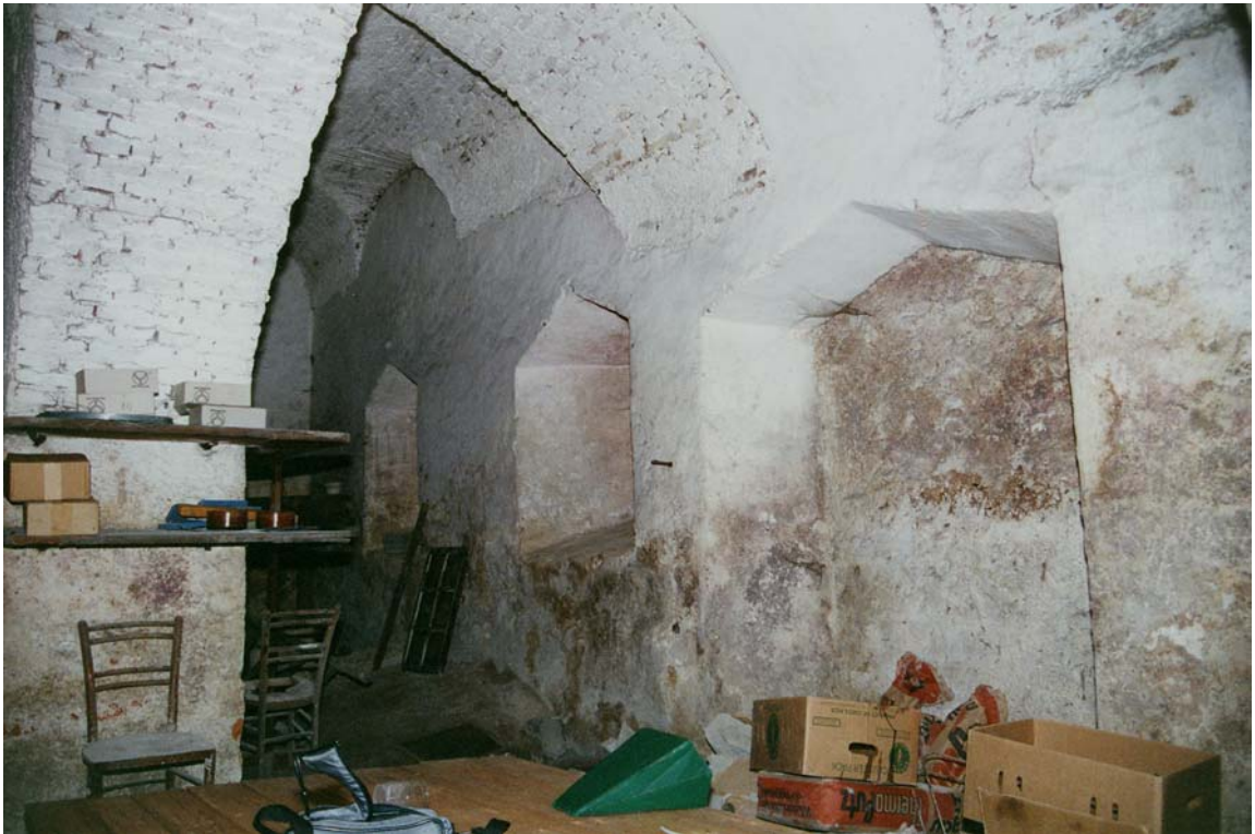
Abb. 88 Neuberg, Klausur, Frateriegebäude, nördlicher Teil von Nordwesten
