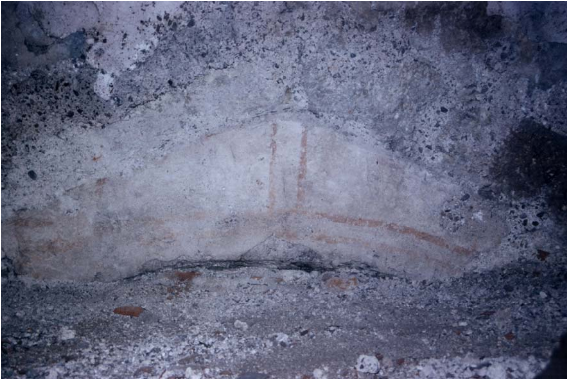
Abb. 94 Neuberg, Klausur, Refektorium, Fugenmalerei im ehemaligen Gewölbebereich (heute Dachboden)
