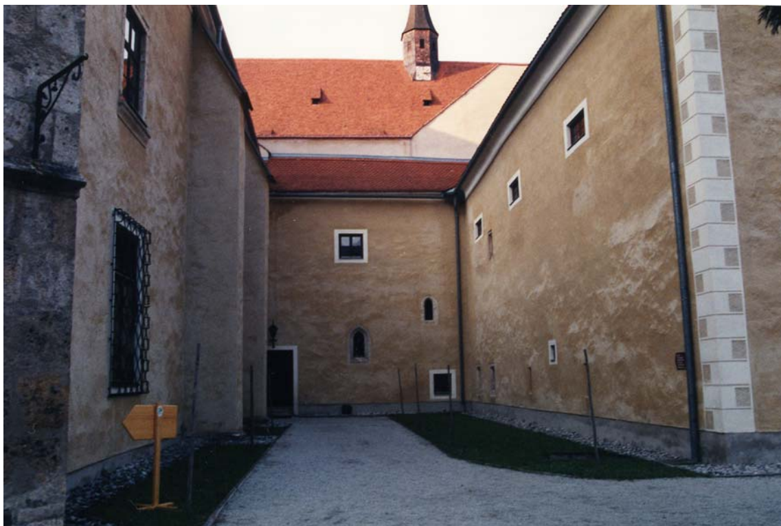
Abb. 90 Neuberg, Klausur, Frateriegebäude, Treppenaufgang und Refektorium von Süden
