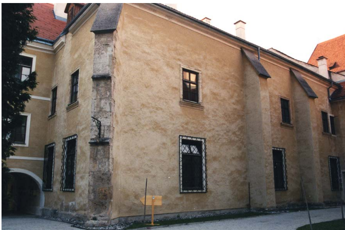
Abb. 91 Neuberg, Klausur, Refektorium von Südosten
