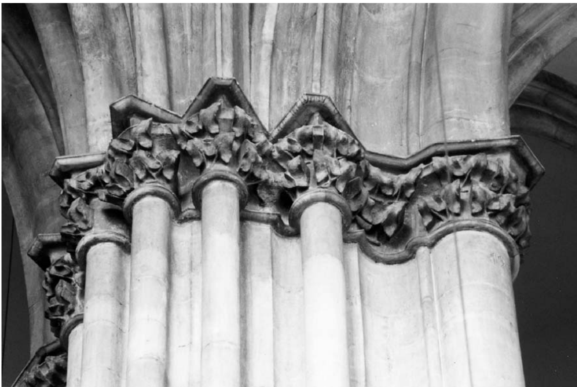
Abb. 231 Wien (W), Dom St. Stephan, Albertinischer Chor, Pfeilerkapitell
