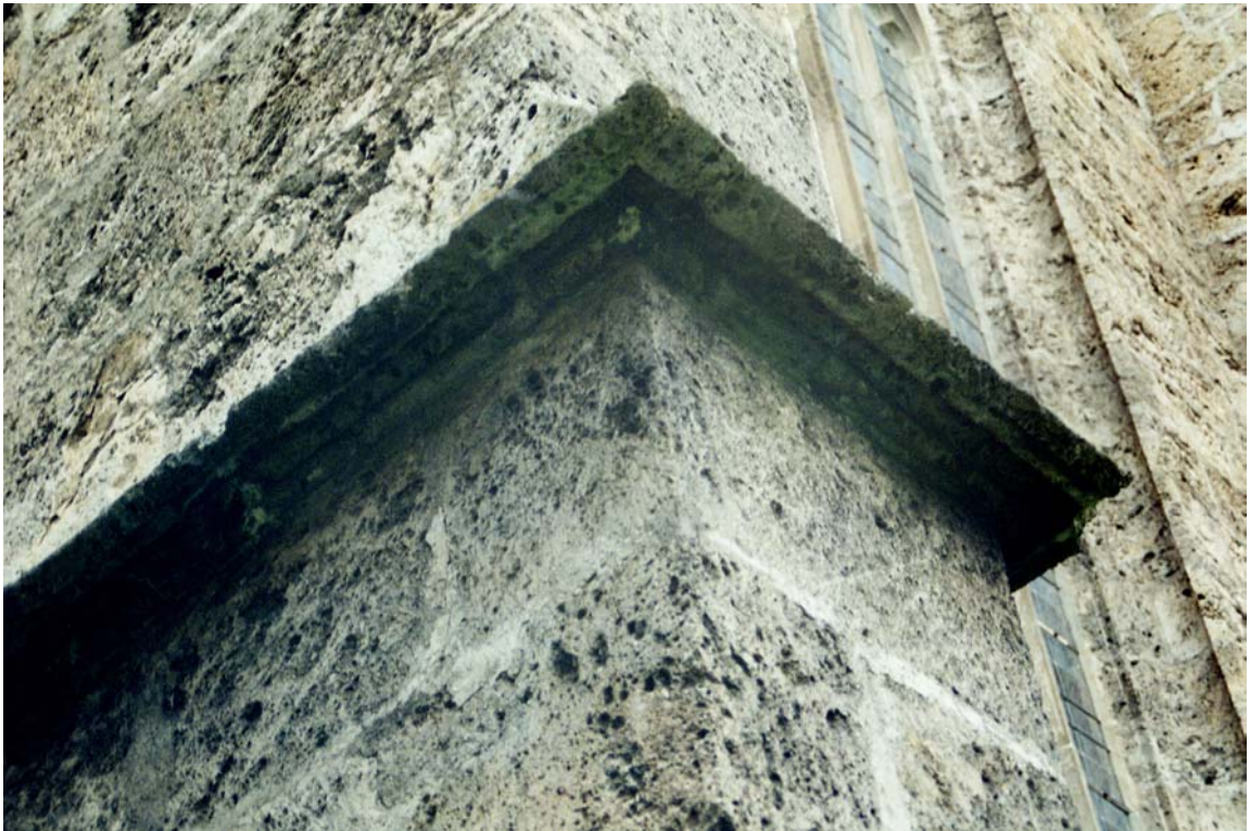
Abb. 52 Neuberg, Klosterkirche, Chor, Südostecke, Sohlbankgesims
