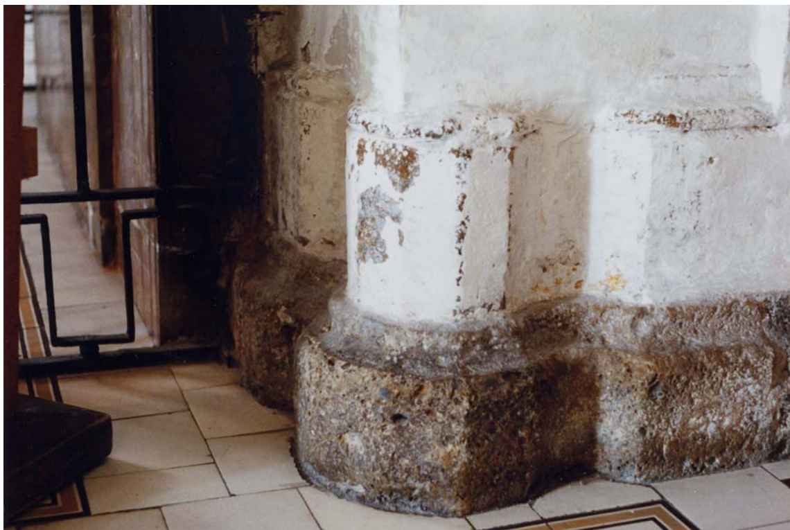
Abb. 182 Mariazell (St), Pfarr- und Wallfahrtskirche Mariae Geburt, freigelegter Pfeilersockel
