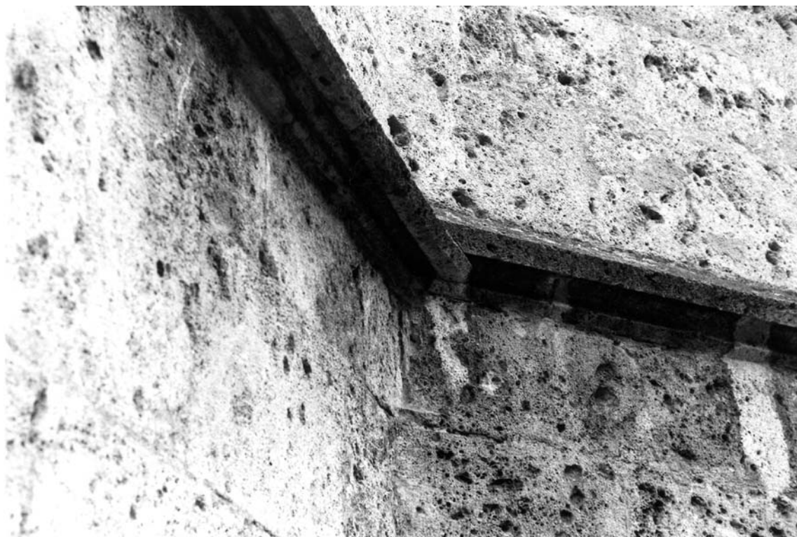
Abb. 55 Neuberg, Klosterkirche, Chor, Nordostecke, Sohlbankgesims
