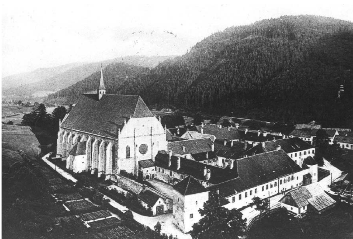
Abb. 11 Neuberg, Klosteranlage von Westen vor Abriß der Vorhalle
