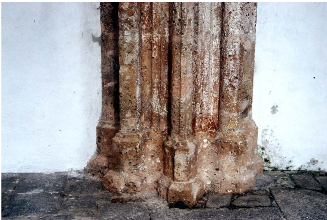
Abb. 22 Neuberg, Klosterkirche, südliche Seitenschiffwand, Wandvorlage unterhalb des Gurtgesimses
