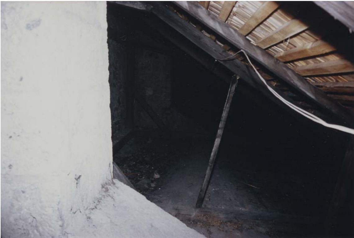
Abb. 66 Neuberg, Klausur, Kreuzgang, Nordflügel, Strebebfeiler im Dach
