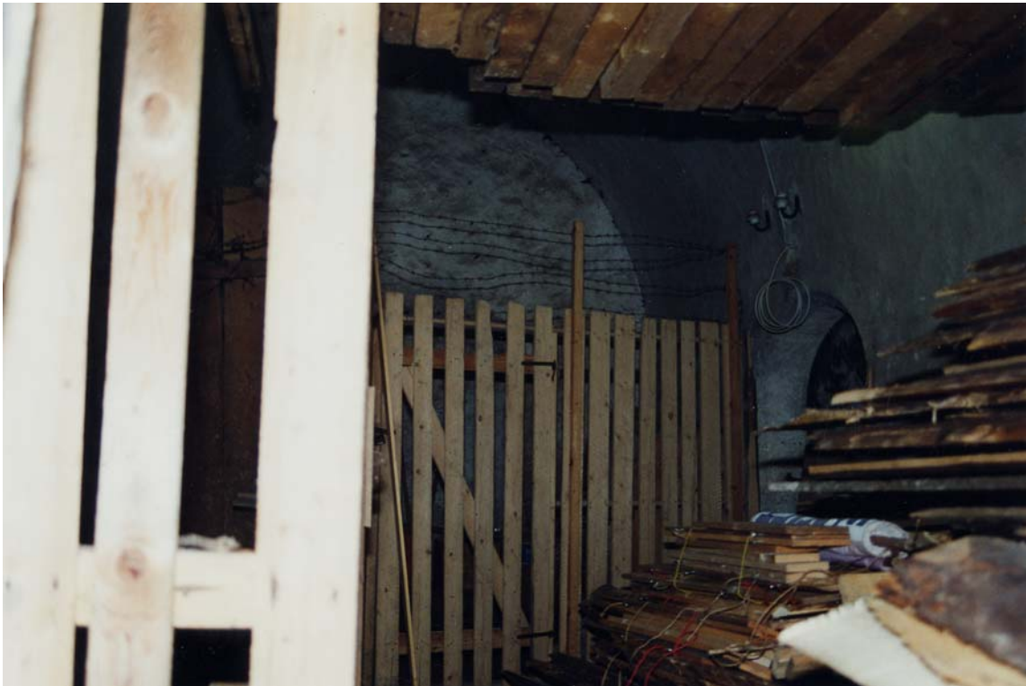
Abb. 82 Neuberg, Klausur, Osttrakt, ehemaliger Ostdurchgang, Torbogen zur Bernardikapelle von Westen
