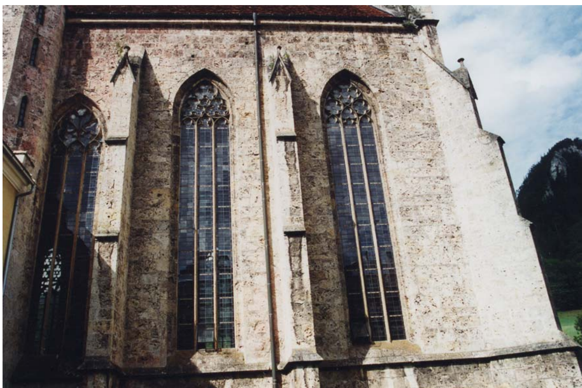
Abb. 51 Neuberg, Klosterkirche, Chor, Gesamtansicht von Süden
