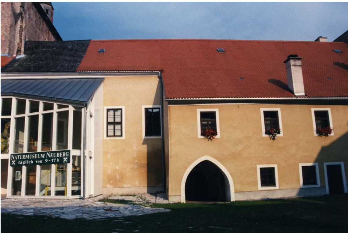
Abb. 95 Neuberg, Klausur, Konversenbau I, Gesamtansicht von Westen
